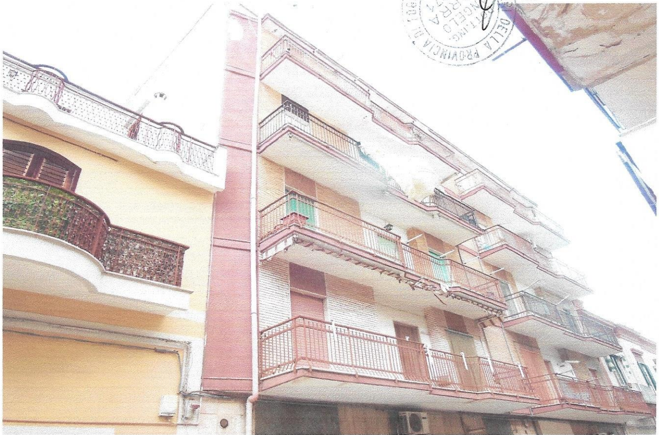
1 – Part. prospetto fabbricato su via G. Lovecchio
