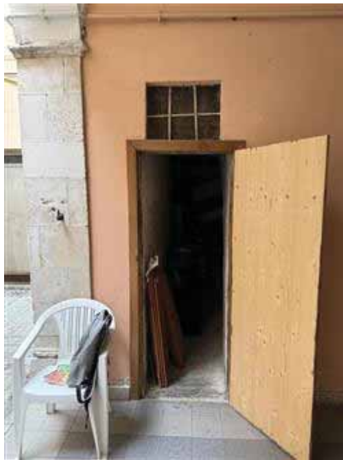
porta di accesso al sub. 19
