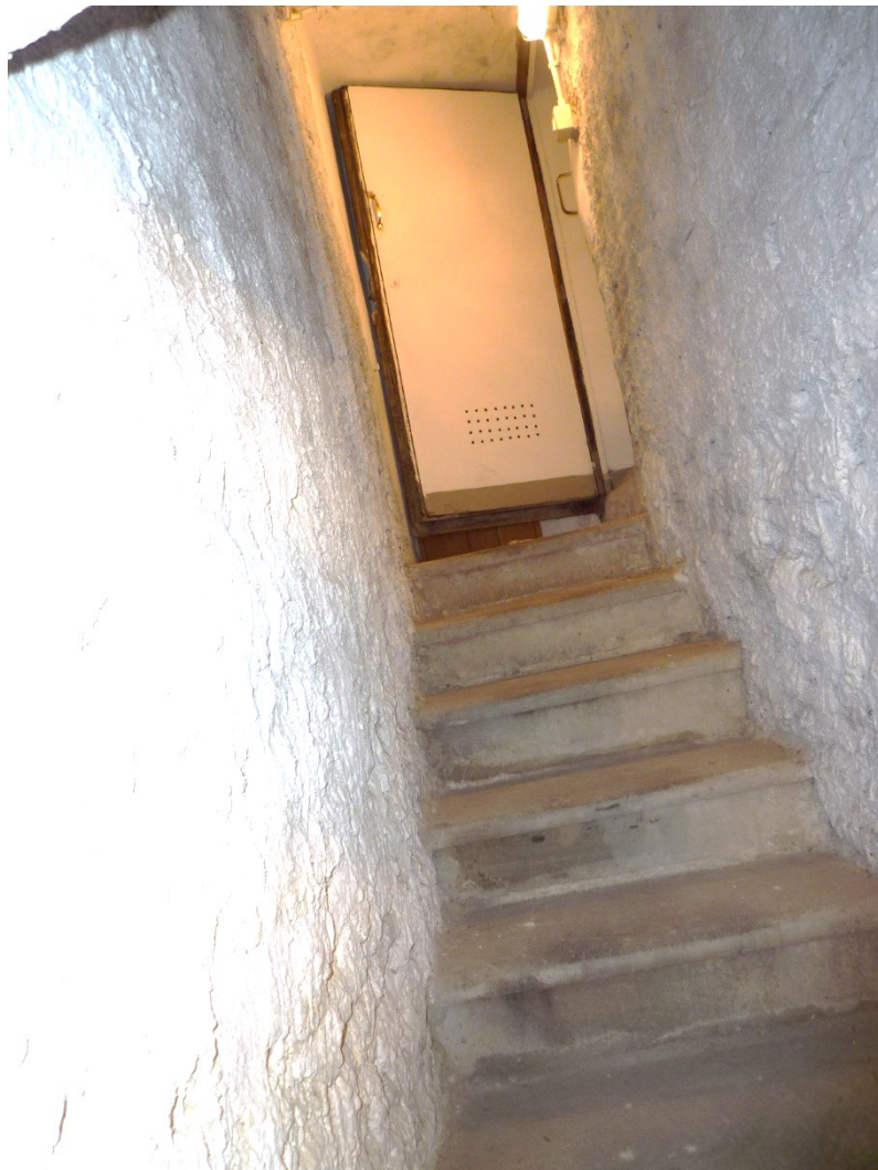
FOTO 16 – Piano seminterrato - cantina
