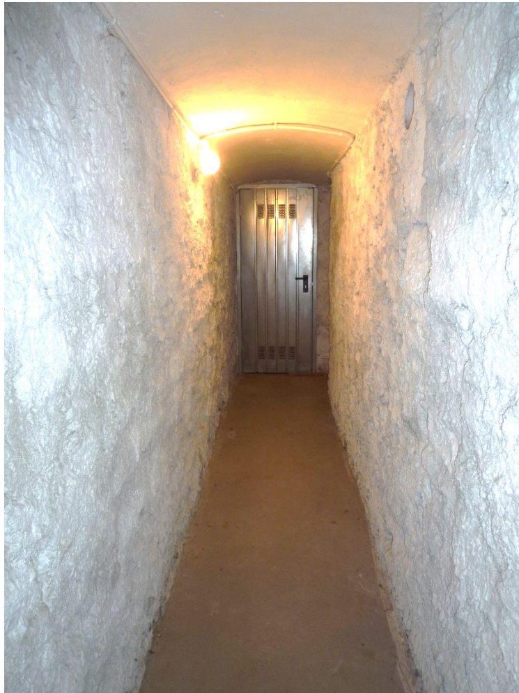
FOTO 17 – Piano seminterrato - cantina
