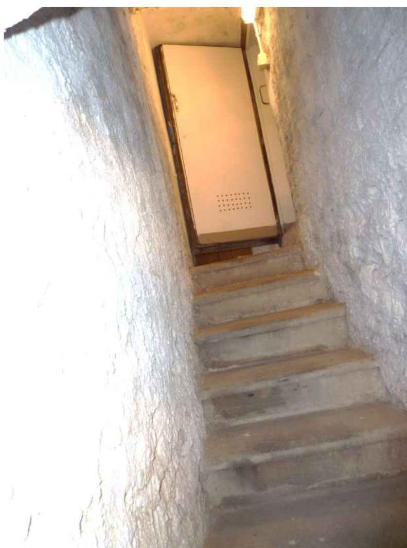
FOTO 16 – Piano seminterrato - cantina
