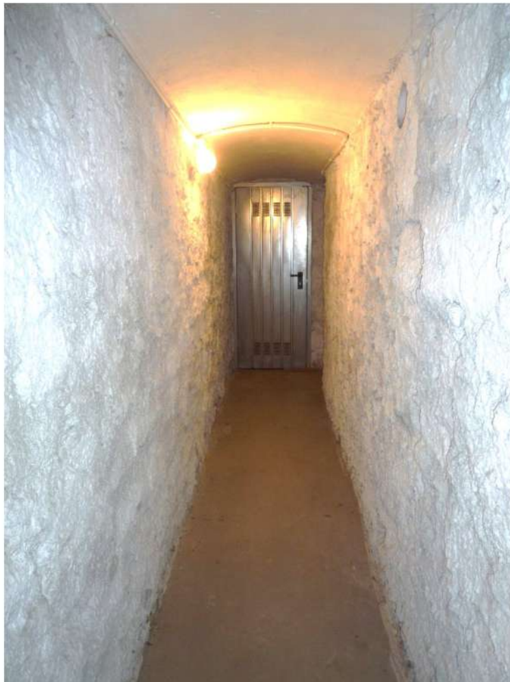
FOTO 17 – Piano seminterrato - cantina
