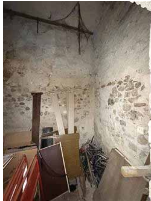
locale del sub.22
