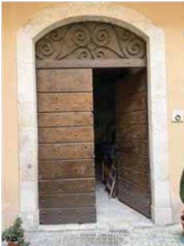
Portone ingresso sub.27
