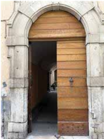
Portone di accesso al palazzo principale
