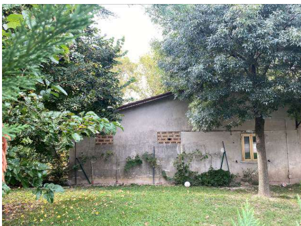
ulteriore vista garage in corpo staccato
