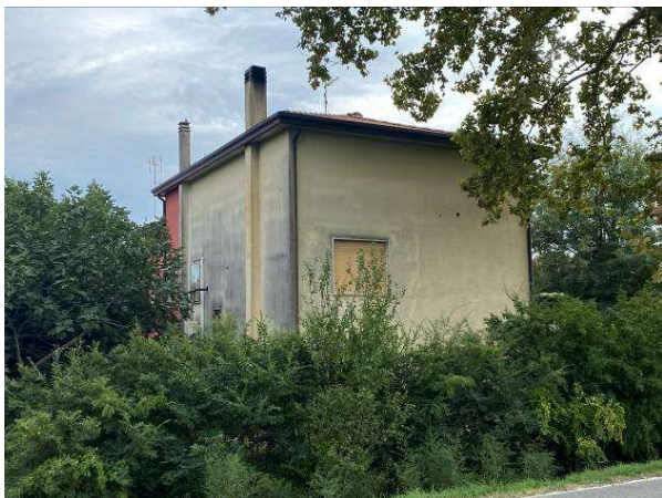
vista prospetto lato nord/est
