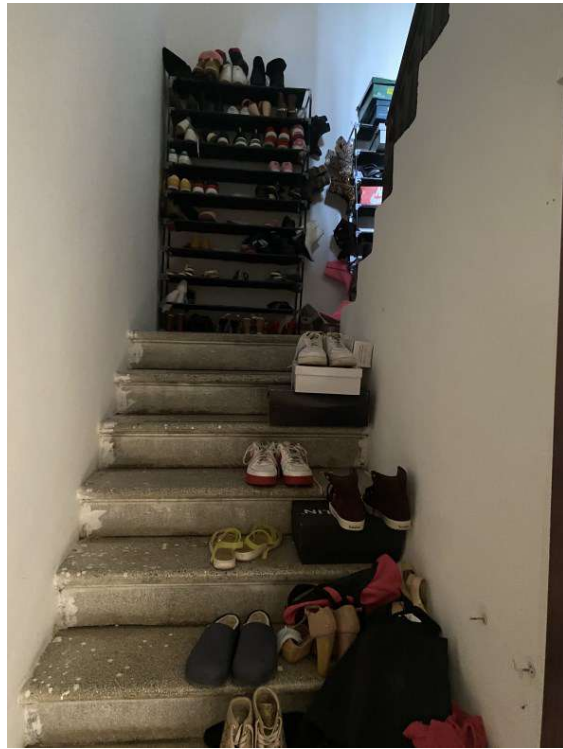
vista scala dal primo piano al secondo piano
