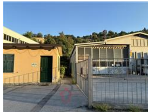
tracciato strada vicinale Pigugea posto a separazione delle due corti dei corpi A e B
