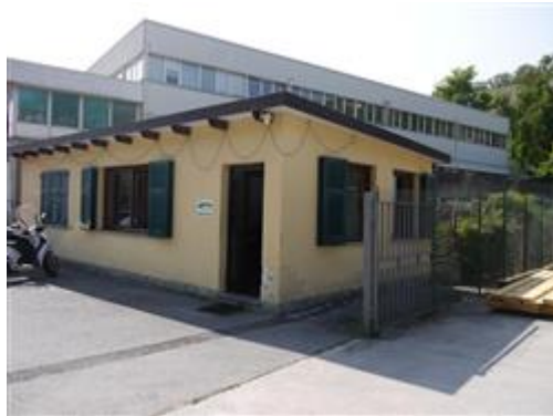
fabbricato adibito ad ufficio - viste generali esterne
