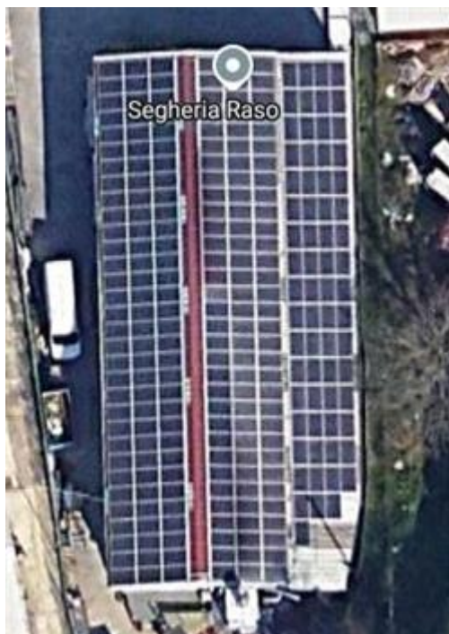
copertura capannone con impianto
