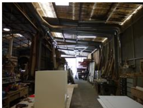
viste interne tettoia ampliamento
