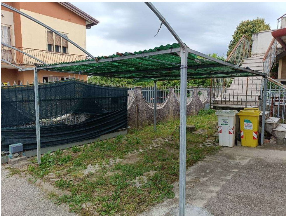
Materiale da rimuovere
