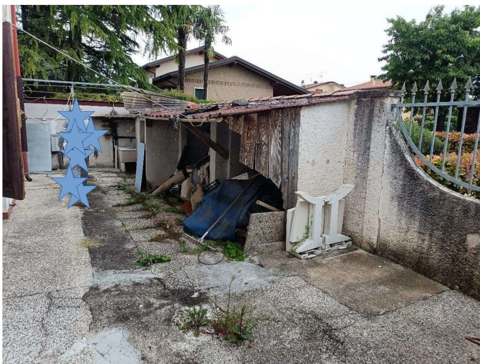
Materiale da rimuovere
