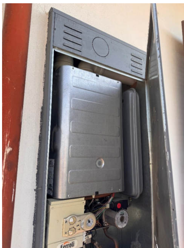
Calderina di Riscaldamento esterna con relativo cronotermostato
