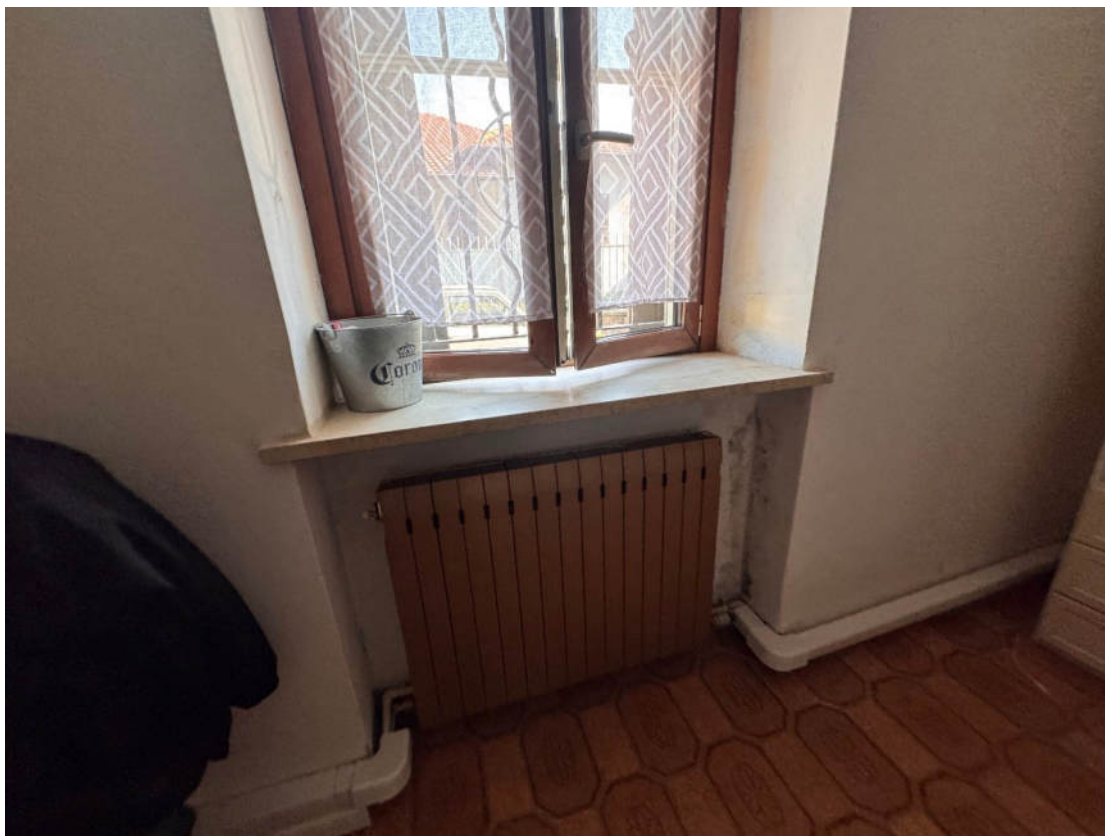
Camera da Letto n.1 – particolare radiatore con tubazioni a vista
