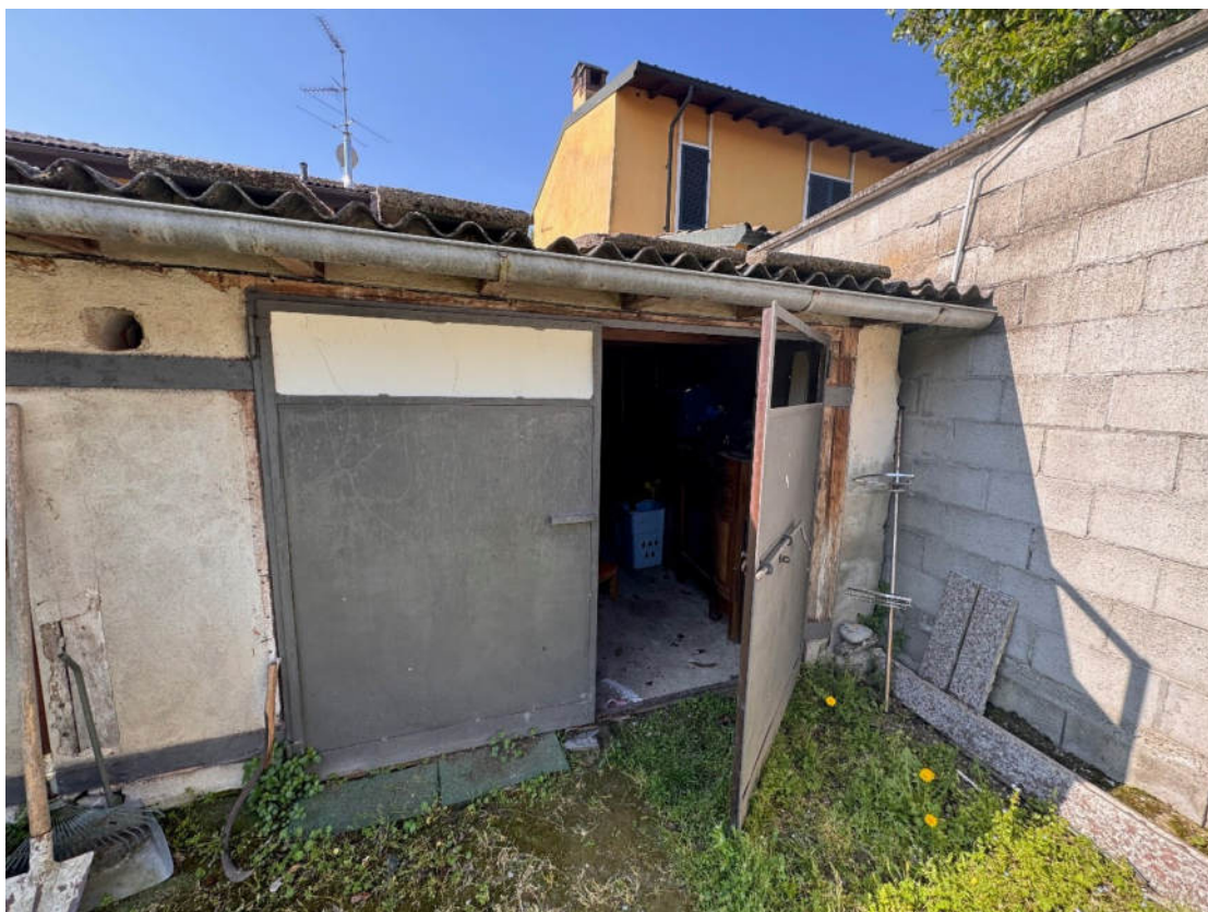
Accesso al Locale Sgombero
