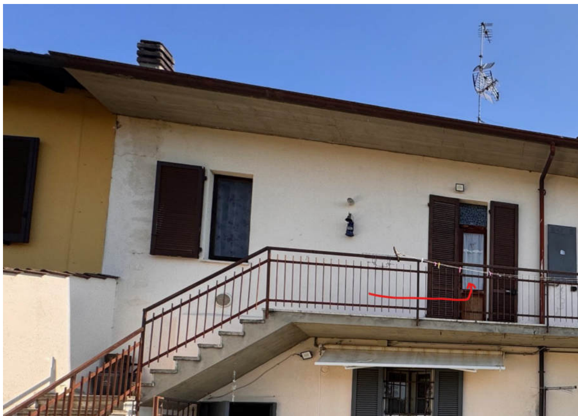
Accesso all'unità immobiliare su ballatoio ove transitano anche gli aventi diritto dell'abitazione adiacente
