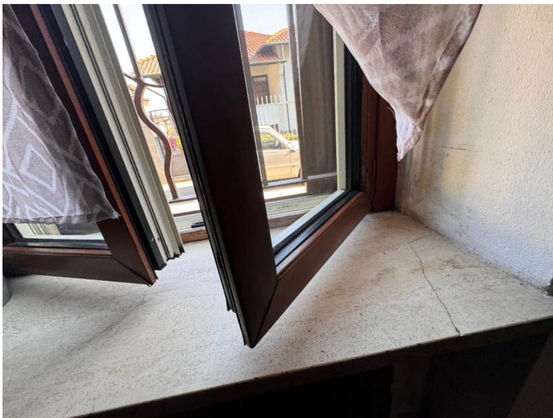
Camera da Letto n.1 – particolare serramento
