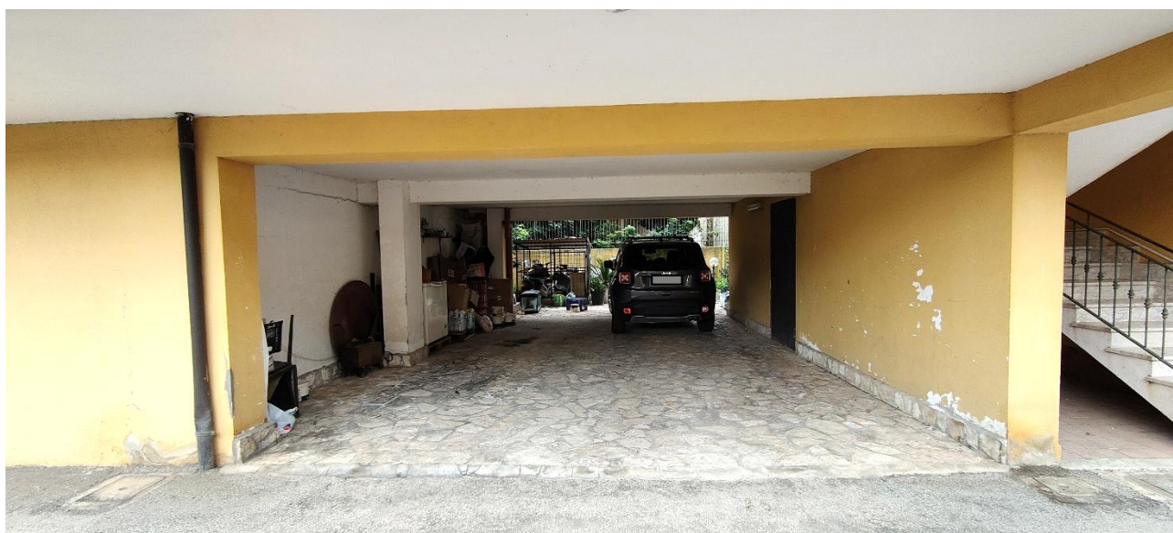
Foto 25 – Pilotis/porticato al piano terra
