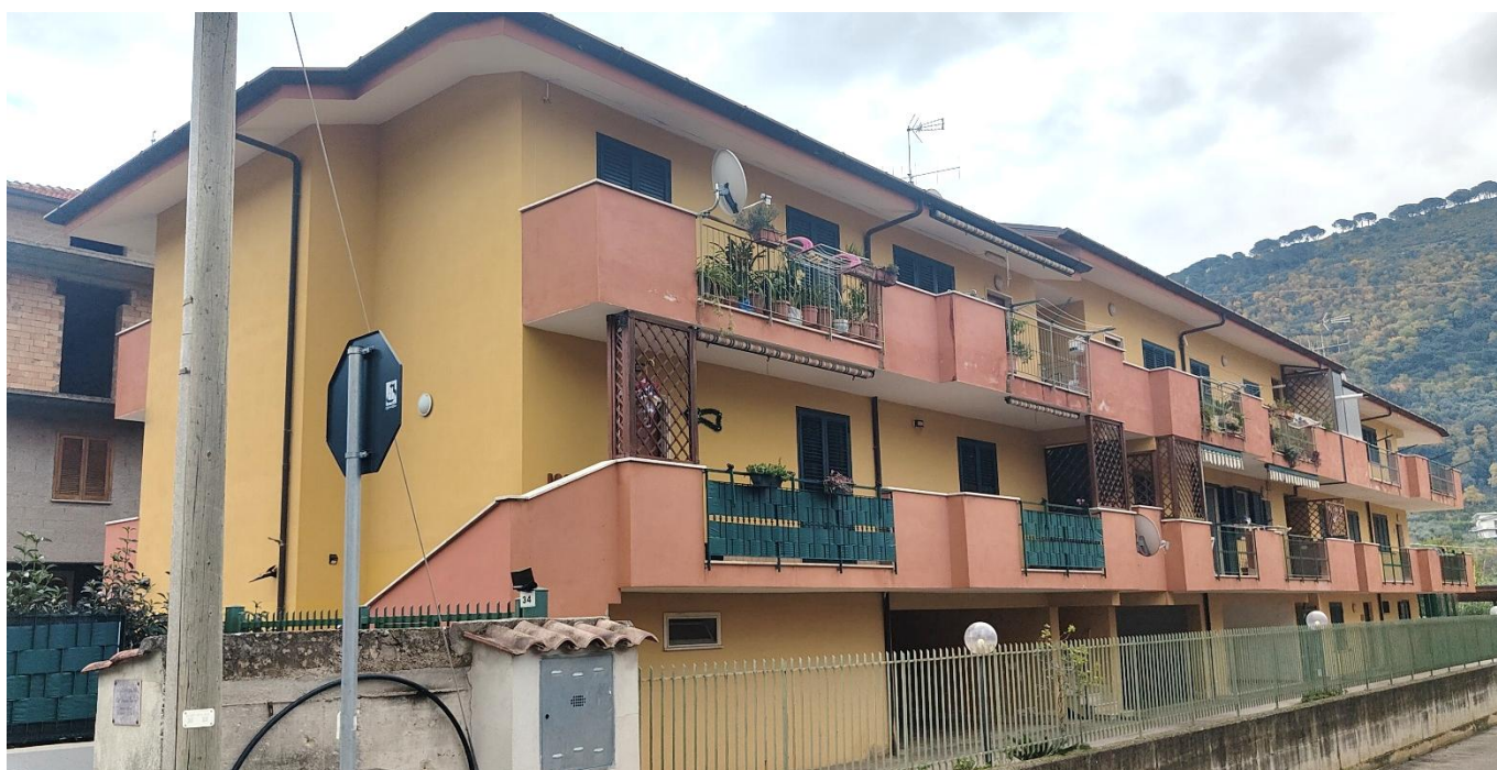
Foto 1 – Vista esterna fabbricato da Via Querce
