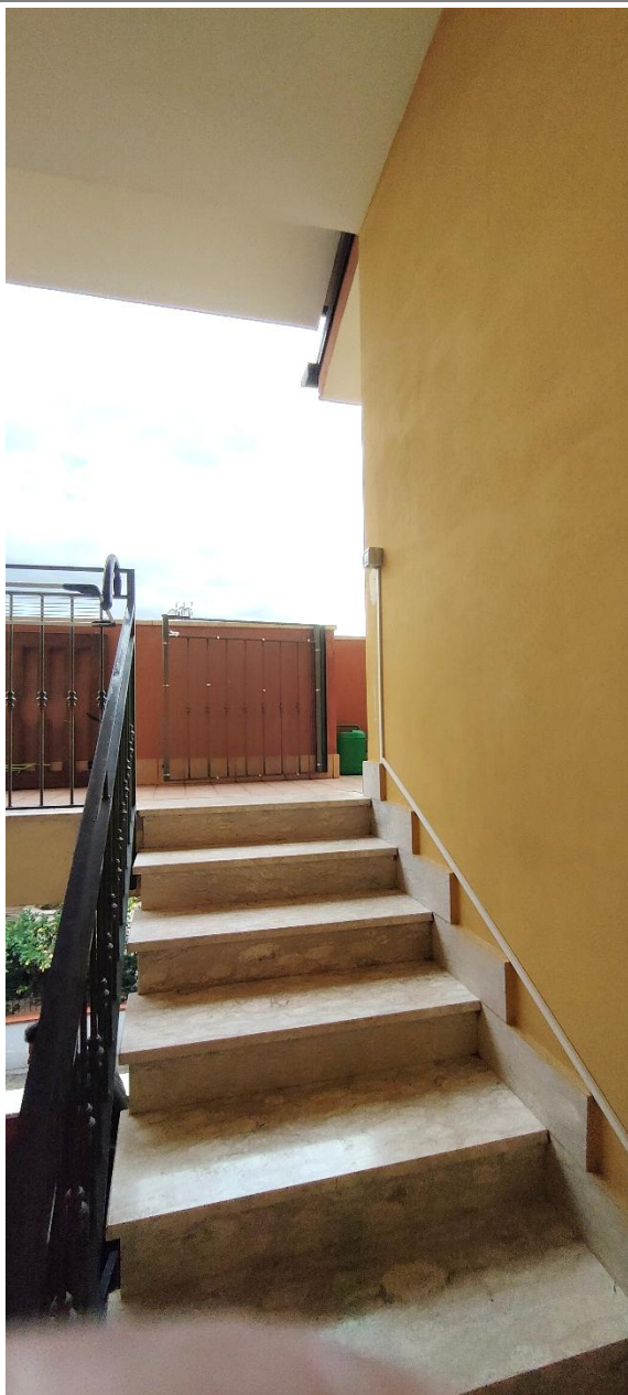
Foto 3 – Scala comune di accesso
