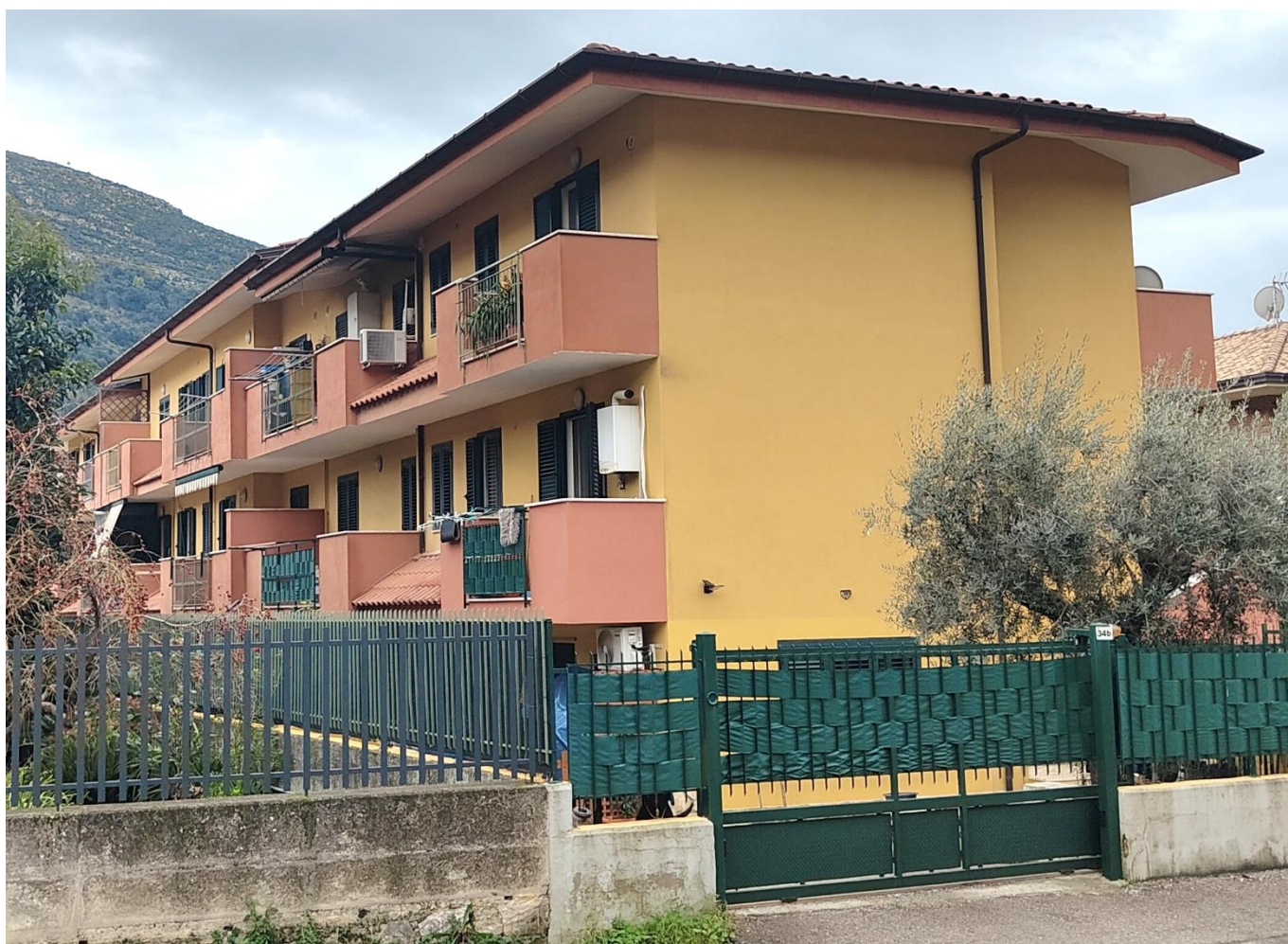
Foto 2 – Vista esterna fabbricato da Via Querce
