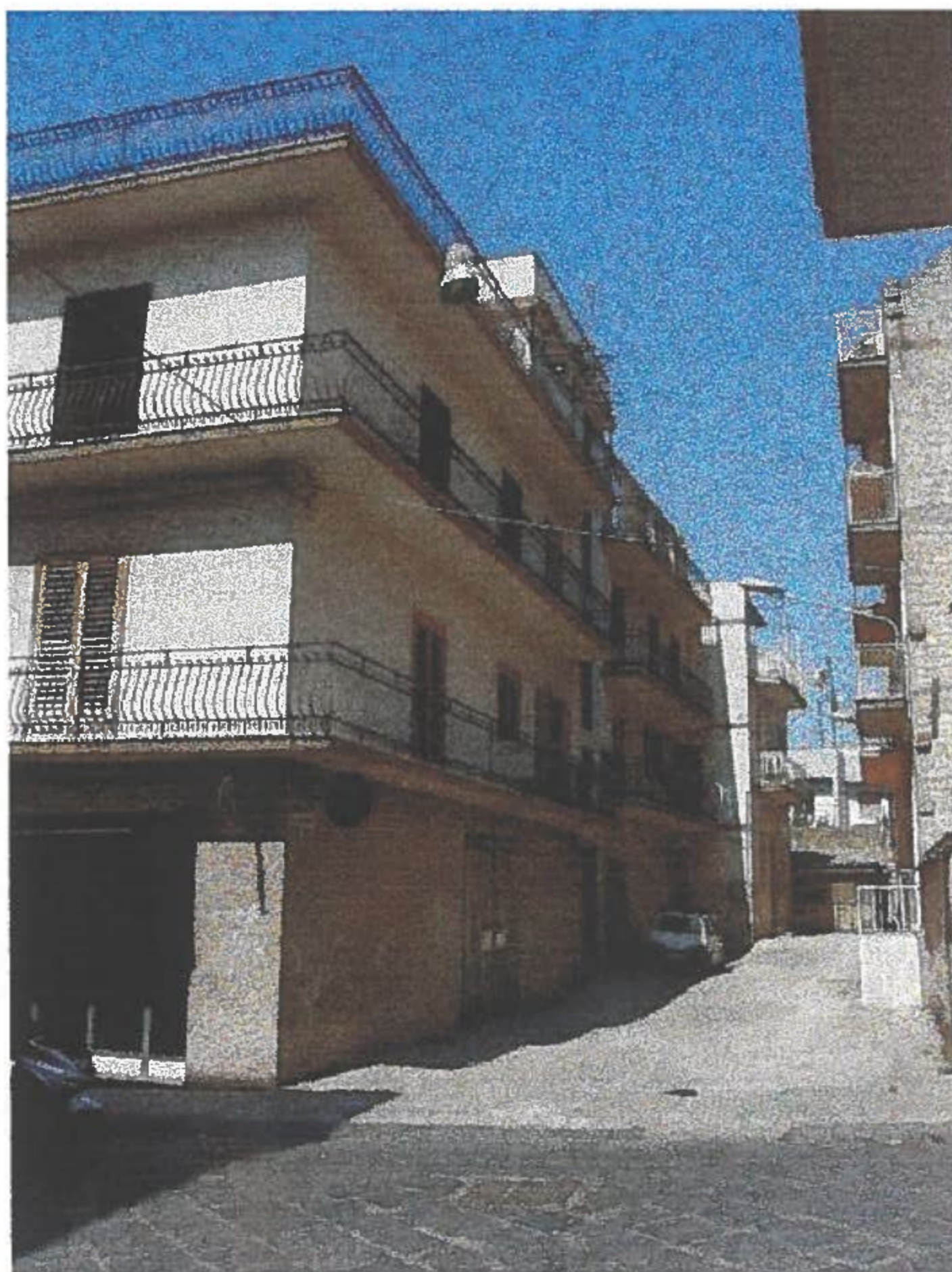
Foto 2: Vista da Vicolo di Via Cosenza
