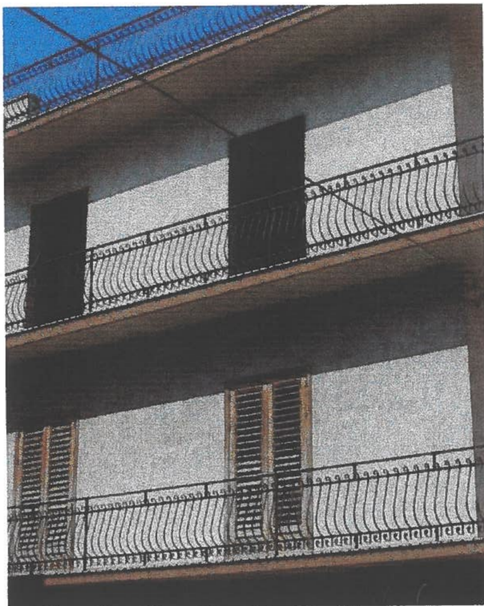
Foto 7: Particolare I, II e III Piano (terrazza) da Via XX Settembre
