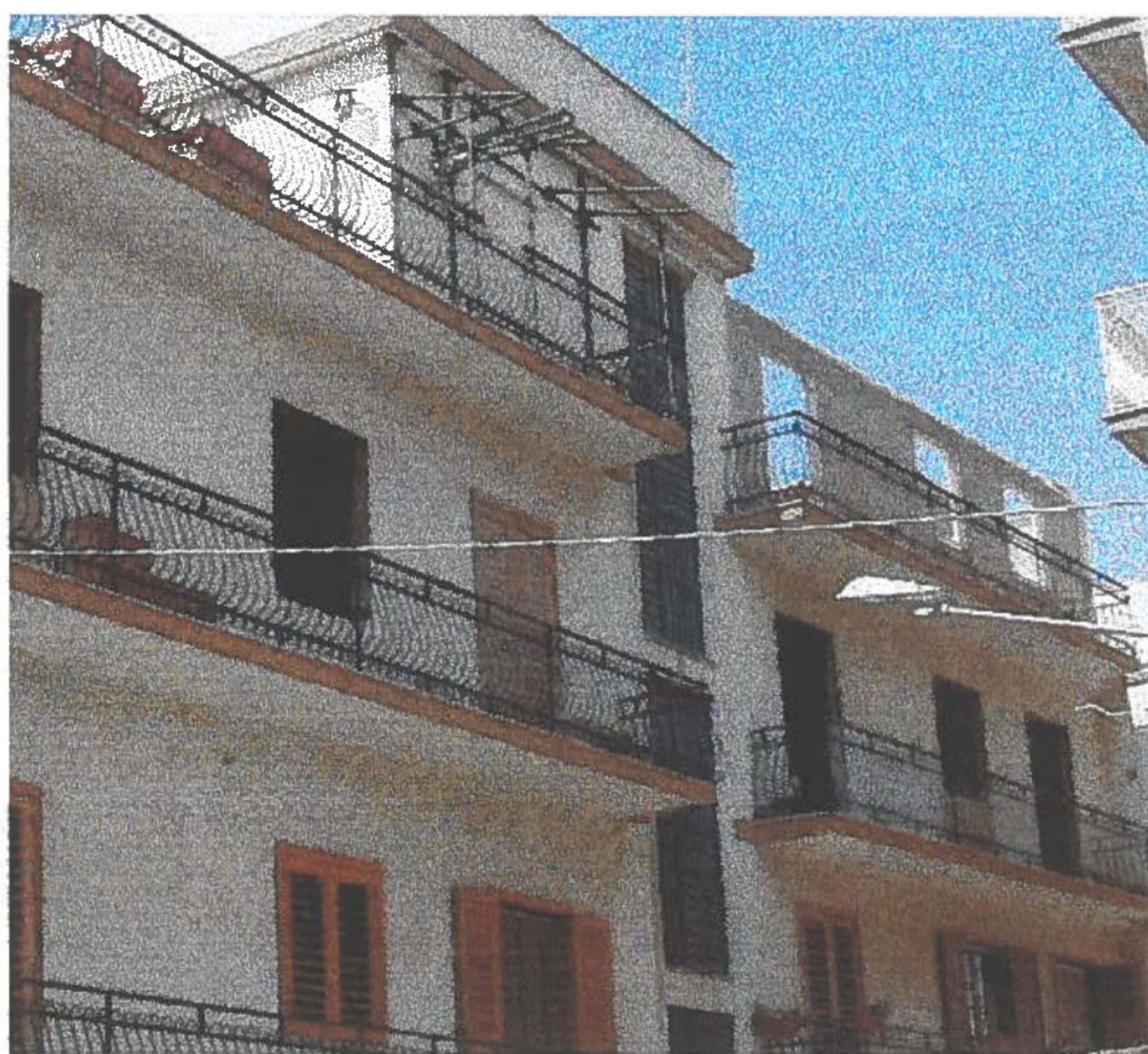
Foto 6: Particolare II e III Piano (terrazza) da Vicolo di Via Cosenza
