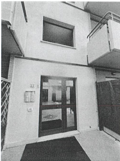
ingresso al condominio
