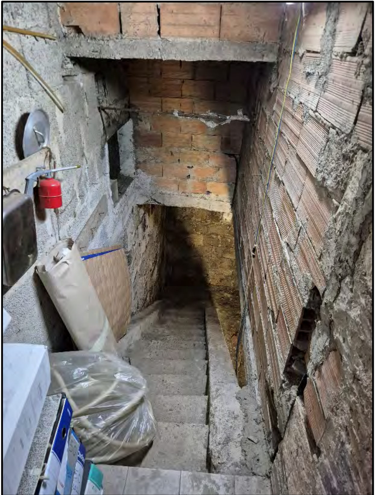
Vista della scala di accesso alla cantina
