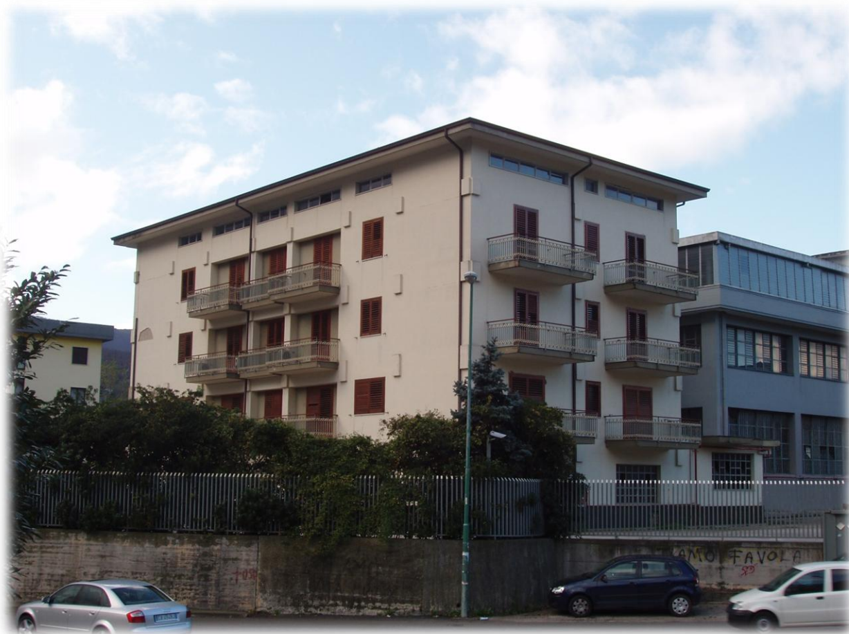
Foto n.5-6 – Vista generale e particolare della palazzina uffici
