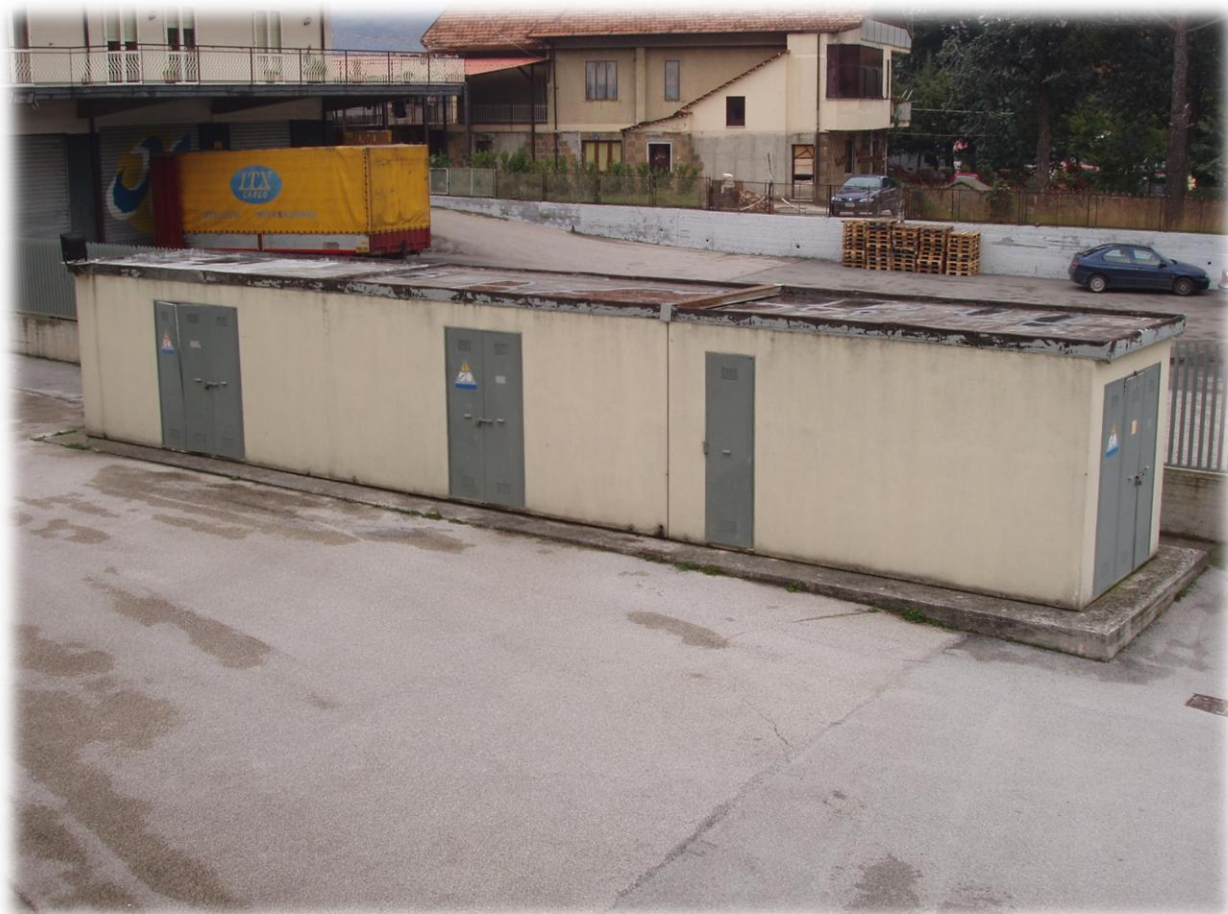
Foto n.7-8 – Ingresso principale e cabina elettrica
