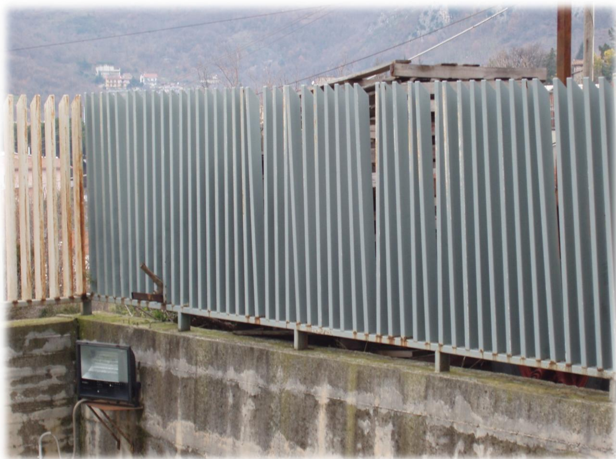
Foto n.37-38 – Impianto di depurazione e particolare della recinzione
