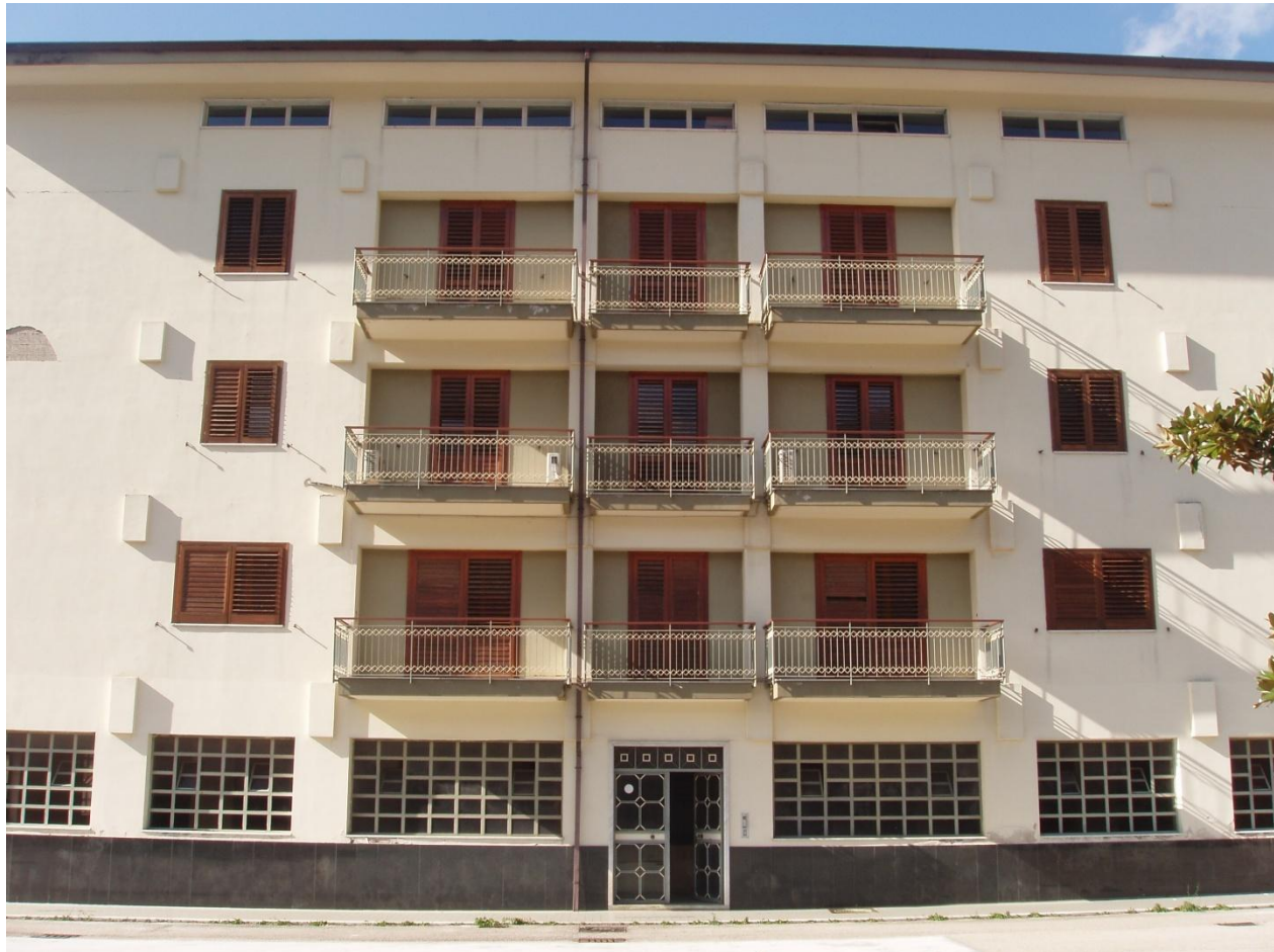
Foto n.9-10 – Fronte principale della palazzina uffici e dettaglio
