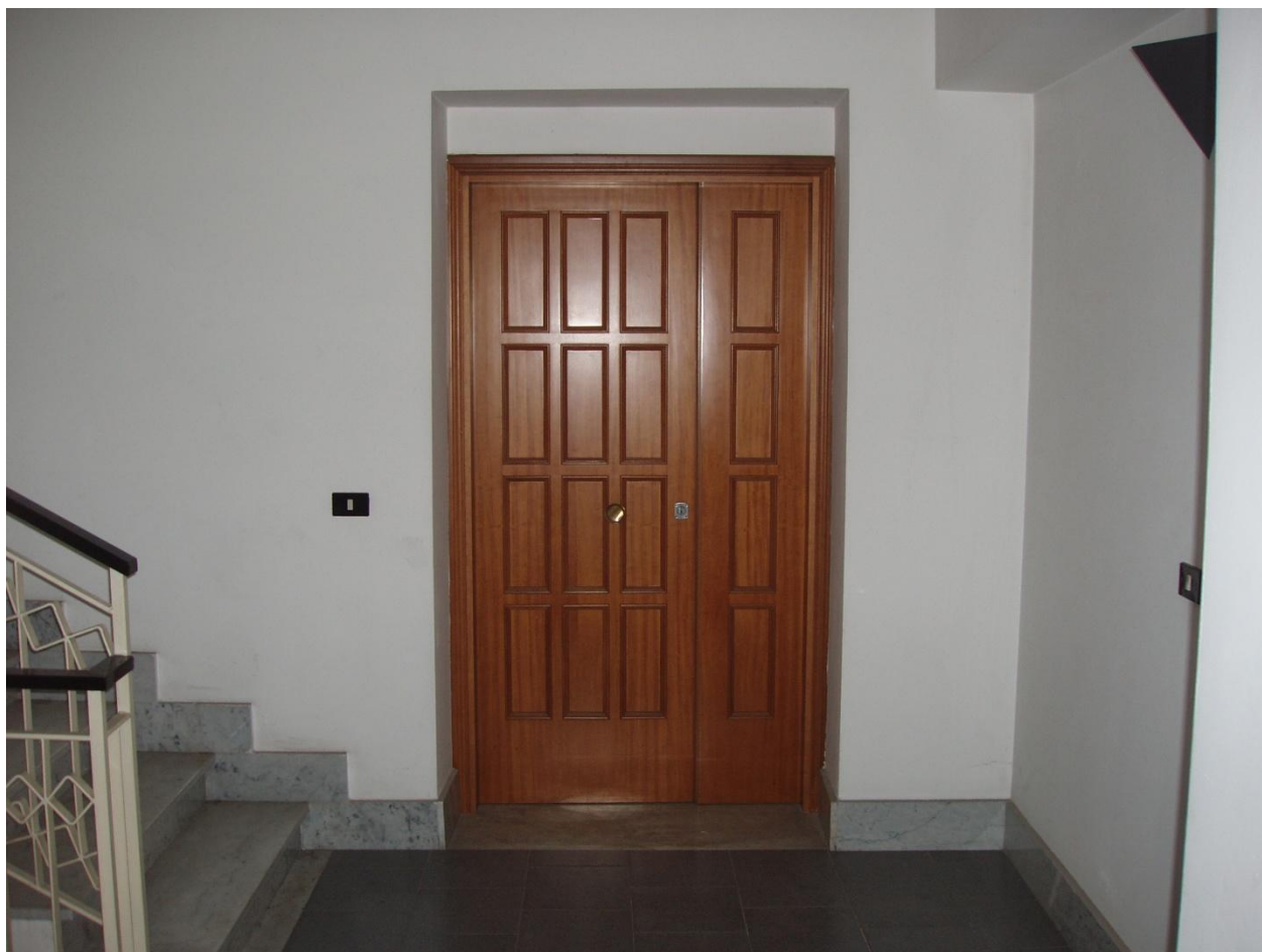
Foto n.68-69-70 – Vano scala e portoncini d'ingresso ai vari appartamenti
