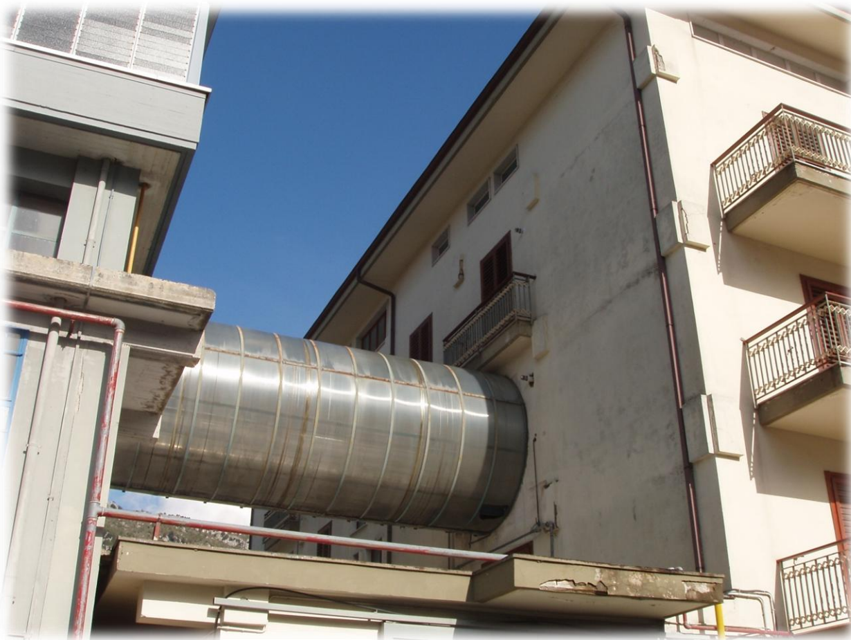
Foto n.14-15 – lato Ovest dell'opificio industriale e tunnel di comunicazione uffici/area produttiva
