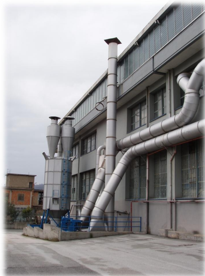
Foto n.16-17 – lato Ovest e lato Est
