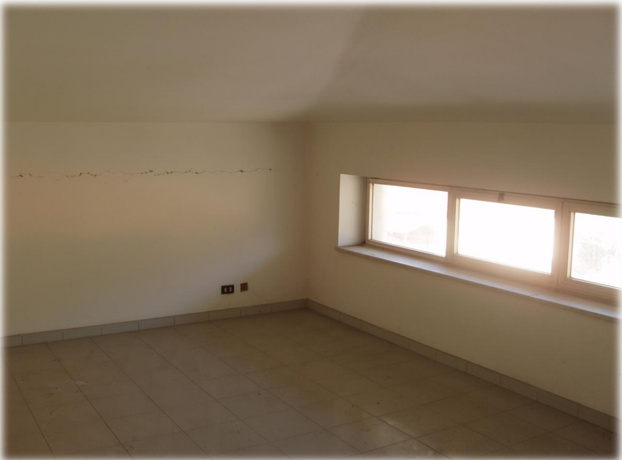
Foto n.87-88-89 – Locali sottotetto, rifiniti in tutto tranne che negli infissi interni
