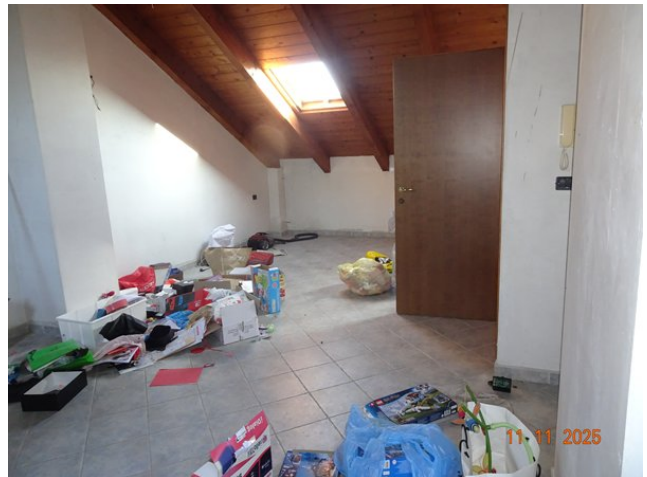
Sottotetto non abitabile
