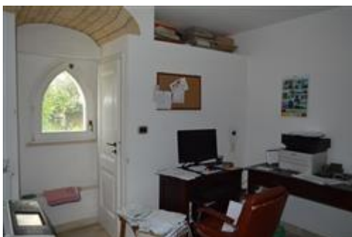
deposito a PT - wc non autorizzato
