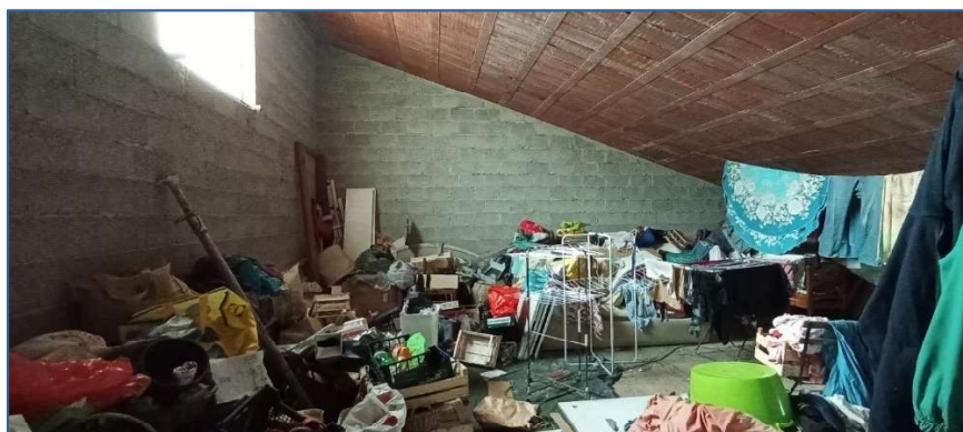
P.I., magazzino (ingresso da soggiorno PT e botola da magazzino sottostante)
