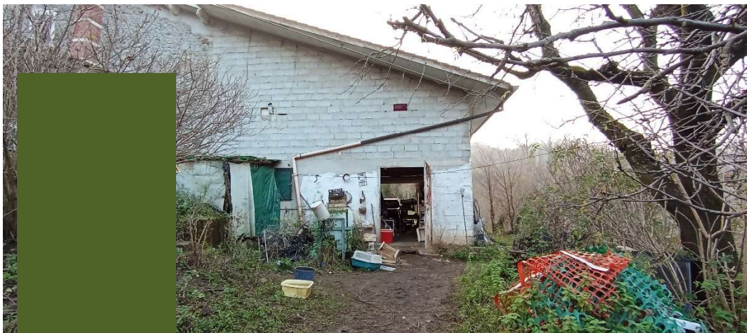
Magazzino prosp. est
