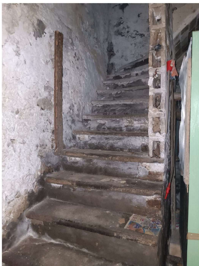
Foto relative al piano II seminterrato.
