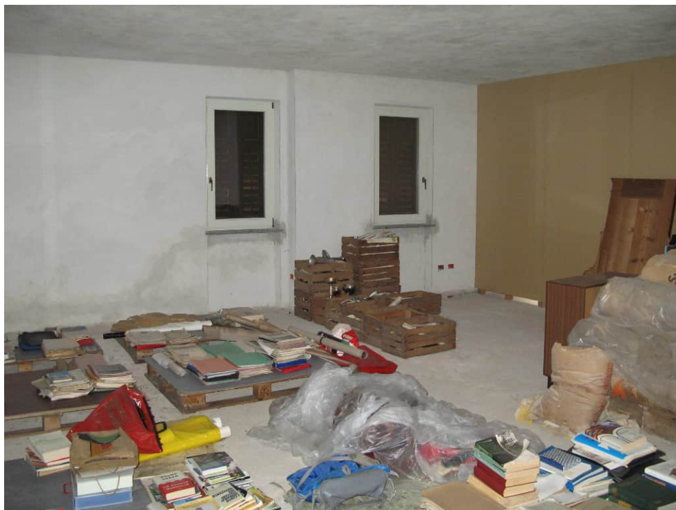
Foto n° 10: Piano terra: spazio nord-ovest destinato ad alloggio (P.M. 1).
