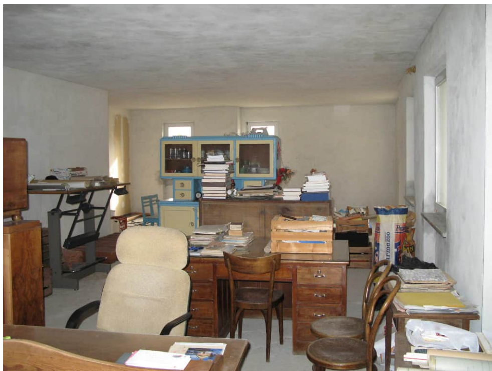
Foto n° 11: Piano terra: spazio sud-est destinato ad alloggio (P.M. 2).
