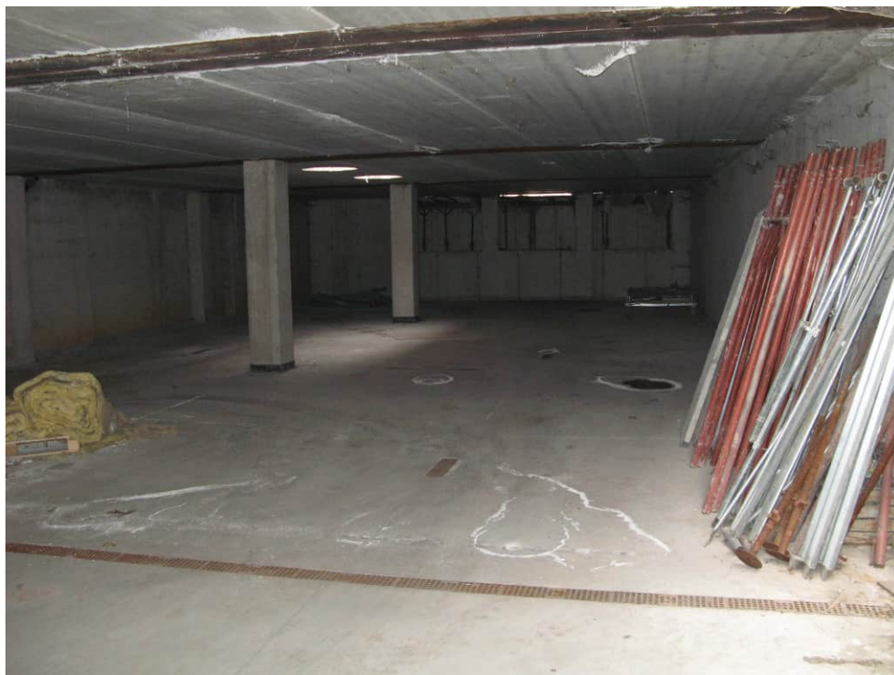
Foto n° 6: Piano interrato: spazio destinato a garage (P.M. 8).
