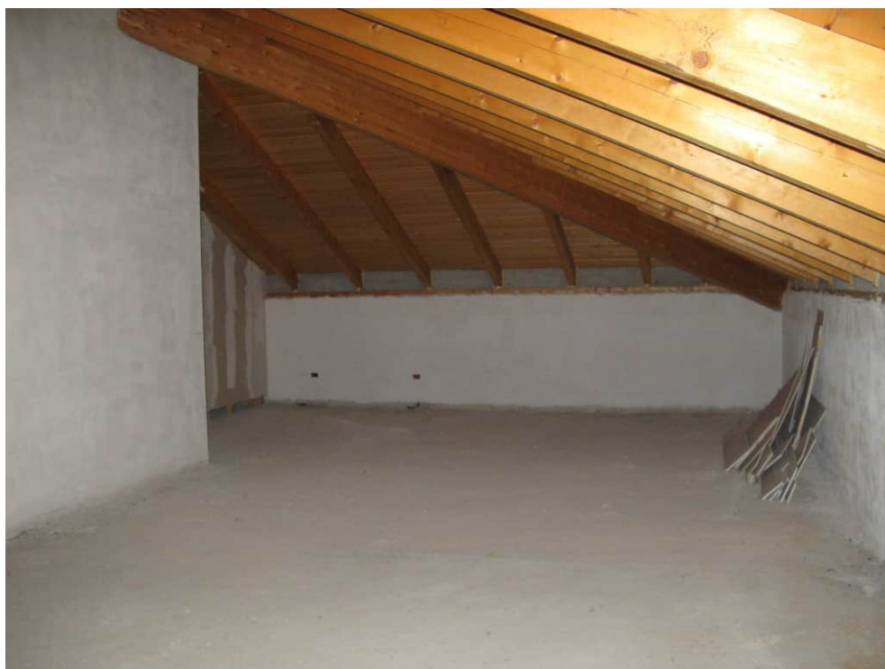
Foto n° 21: Piano terzo: spazio sud-est destinato a soffitta (P.M. 7).
