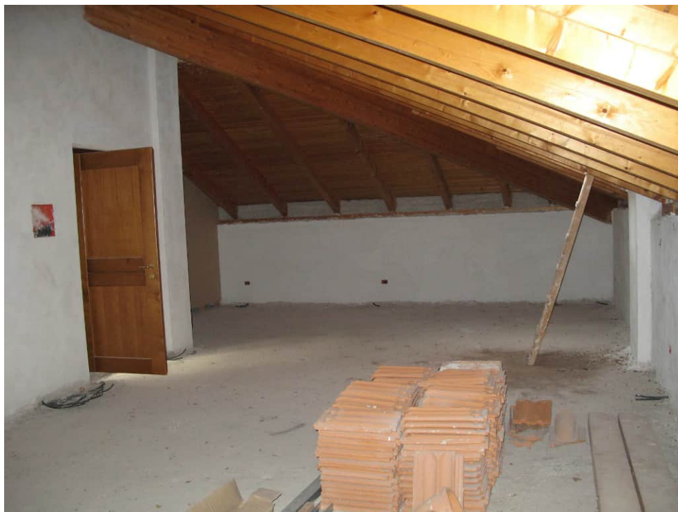
Foto n° 20: Piano terzo: spazio nord-ovest destinato a soffitta (P.M. 7).
