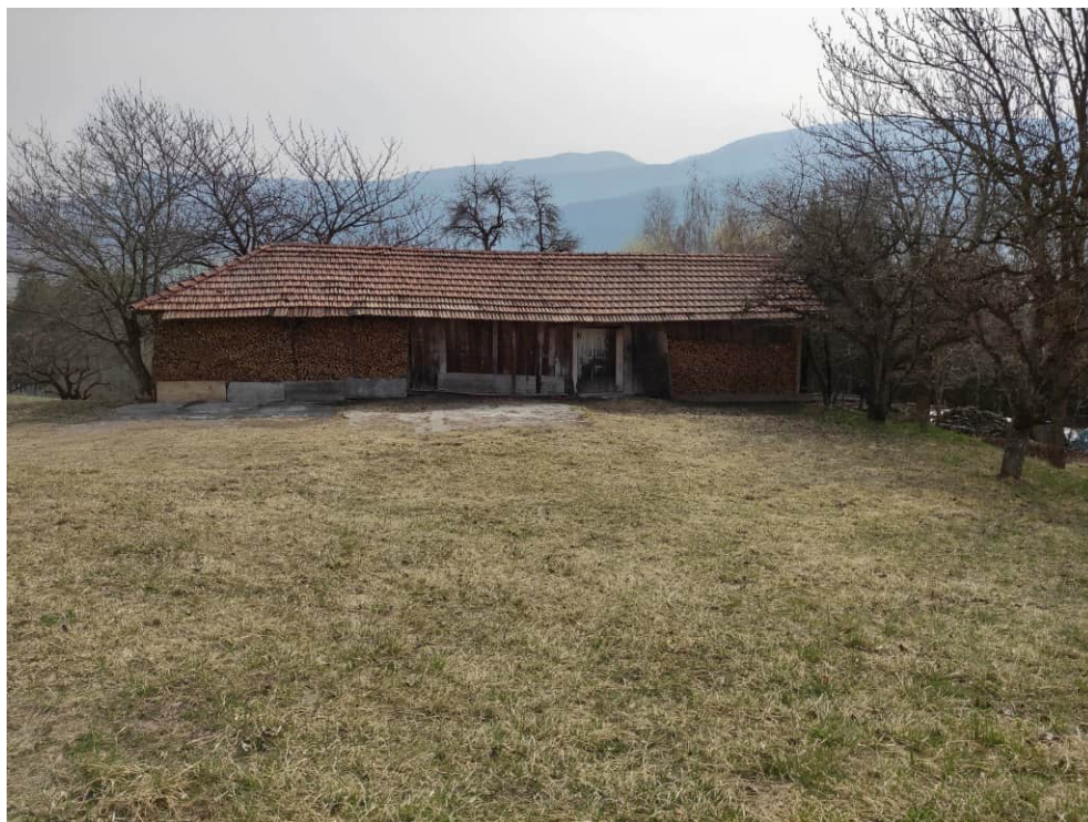
Foto n° 28: Vista edificio rustico p.ed. 185 fronte ovest.
