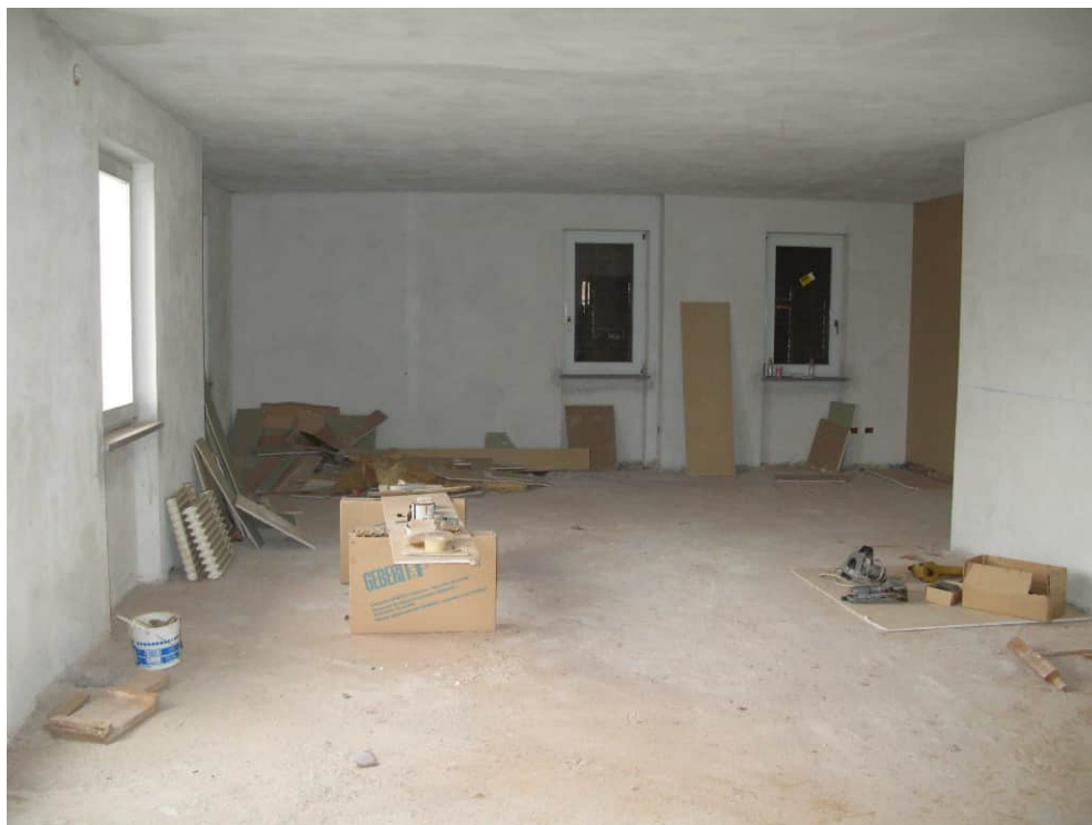
Foto n° 18: Piano secondo: spazio nord-ovest destinato ad alloggio (P.M. 5).
