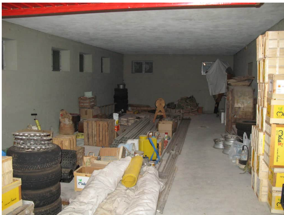
Foto n° 7: Piano interrato: spazio destinato a garage (P.M. 8).
