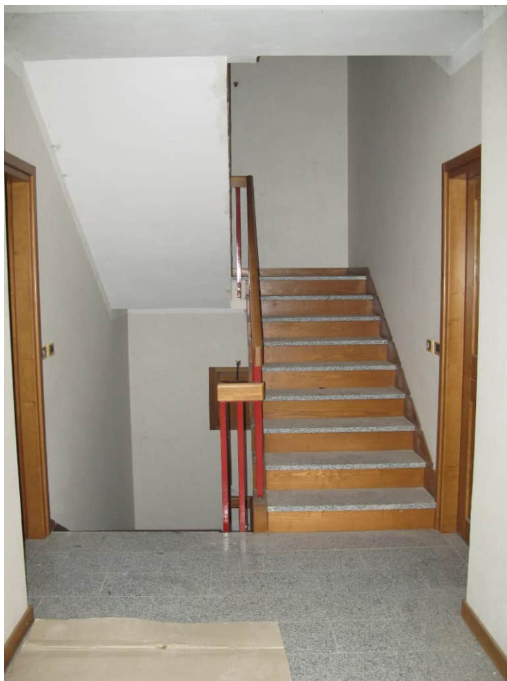
Foto n° 8: Piano terra: vano scala comune.
