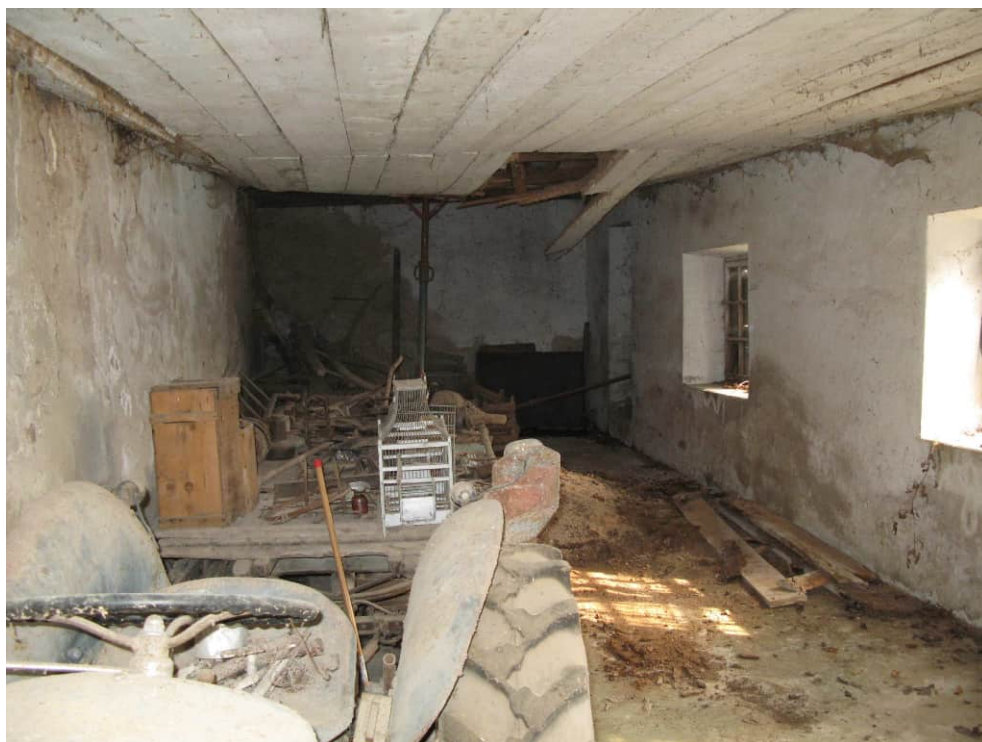
Foto n° 29: Edificio rustico p.ed. 185: piano seminterrato.
