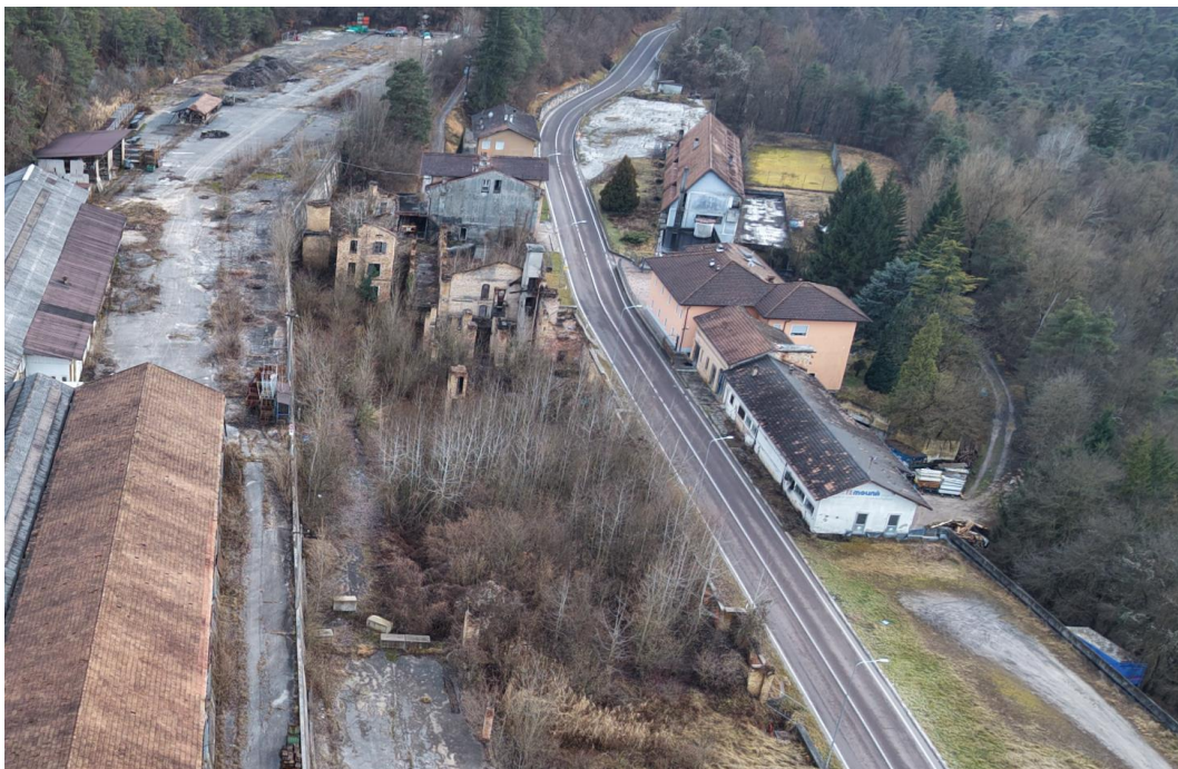
Foto 2- vista da nord
