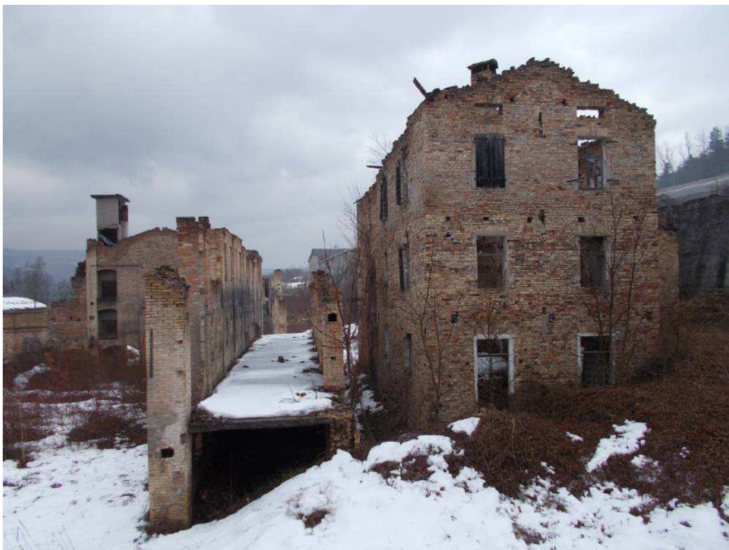
Foto 5- ruderi fabbricati (anno2018)
