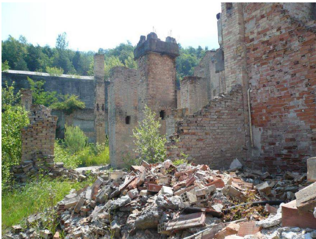
Foto 8- ruderi fabbricati (anno 2018)
