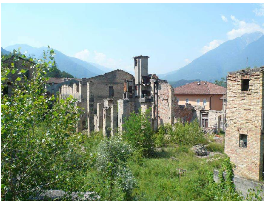
Foto 7- ruderi fabbricati (anno 2018)
