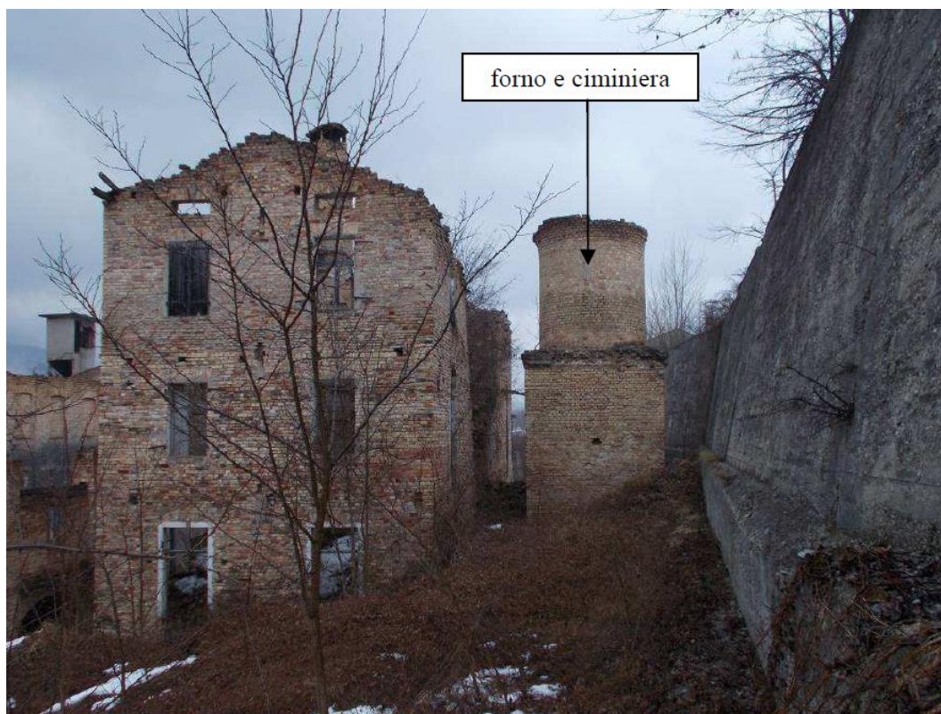
Foto 6- ruderi fabbricati (anno 2018)
