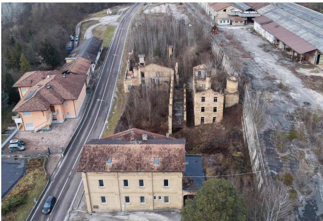
Foto 3- vista da sud
