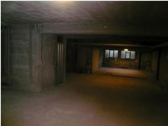
Piano interrato: cantina e posto auto p.m. 5
