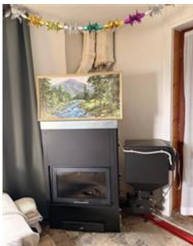
Stufa a pellet idro con funzione di riscaldamento posta nel soggiorno
