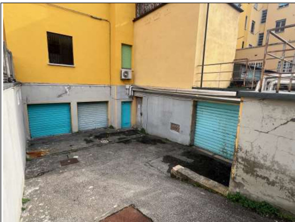
Fabbricato Via Sardegna 11 Bologna
