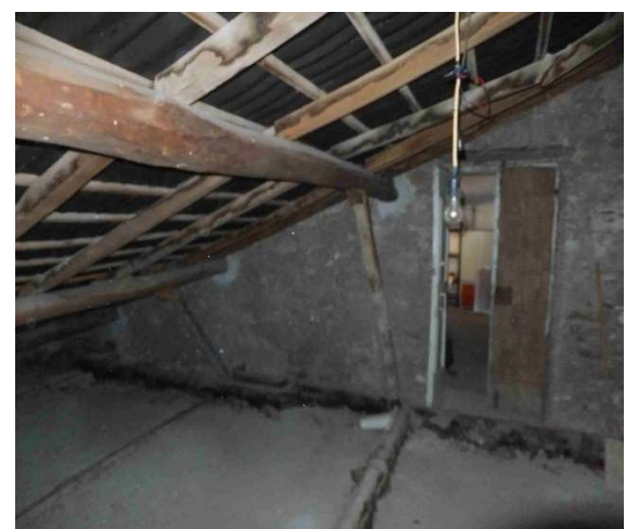
Foto 36, interno P.2, soffitta.
