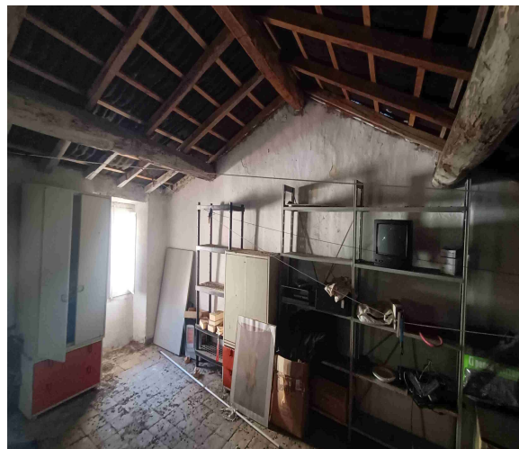
Foto 32, interno P.2, soffitta.
