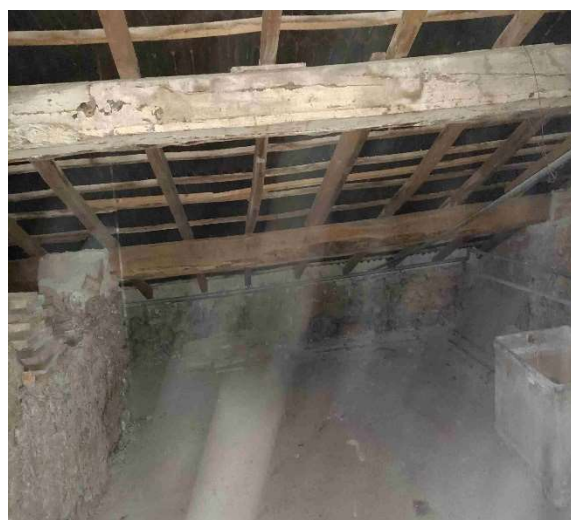
Foto 40, interno P.2, soffitta.
