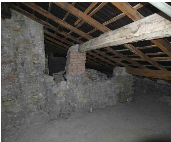
Foto 37, interno P.2, ingresso soffitta.
