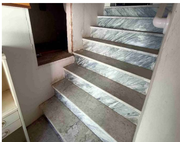
Foto 27, interno P.1 per P.2, scala interna.
