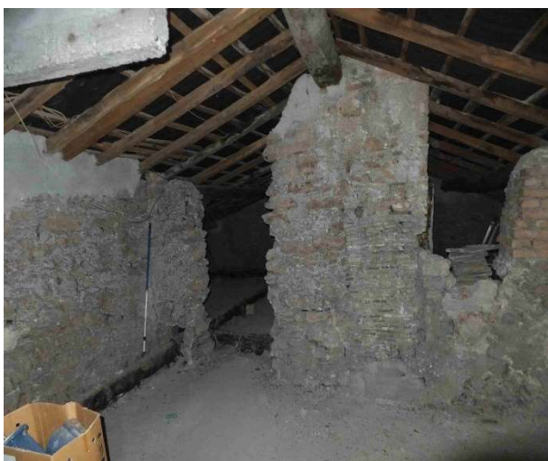
Foto 41, interno P.2, soffitta.
