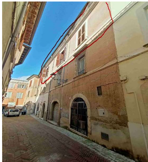
Foto 02, est. fabbricato da Via Consolare.
