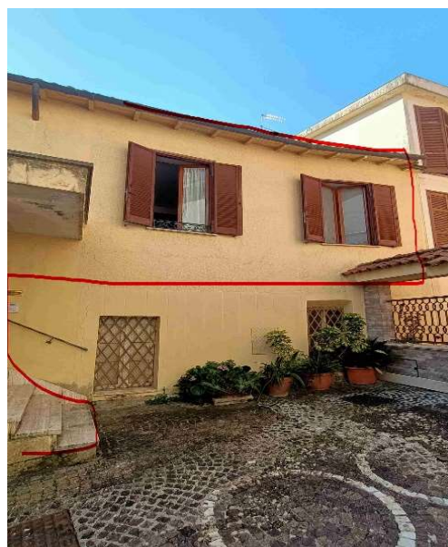
Foto 06, est. fabbric. su Via Regina Margherita.
