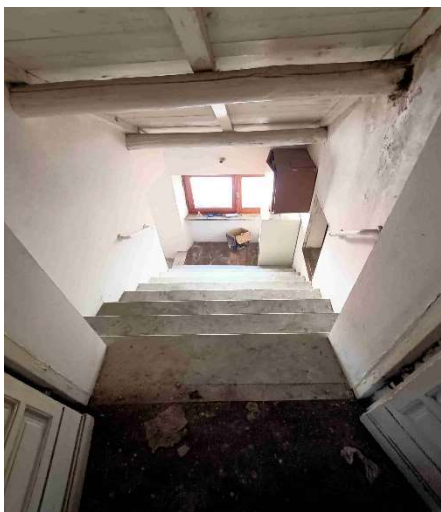
Foto 29, interno P.2, scala interna.
