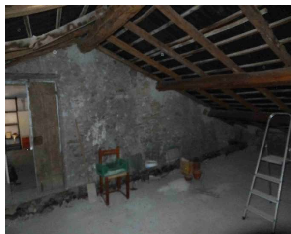
Foto 35, interno P.2, soffitta.
