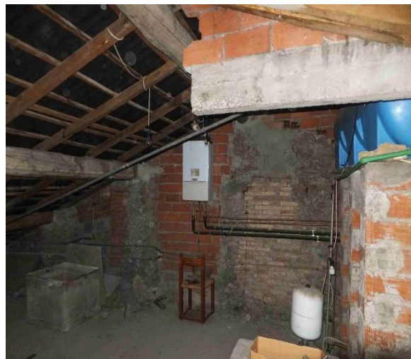
Foto 38, interno P.2, soffitta e c.t. e serbatoio.
