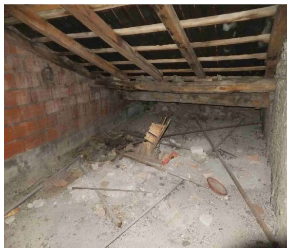
Foto 42, interno P.2, soffitta.
