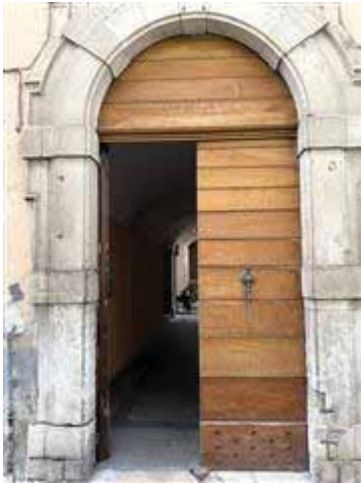
Portone di accesso al palazzo principale
