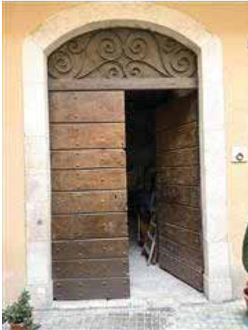
Portone ingresso sub.27
