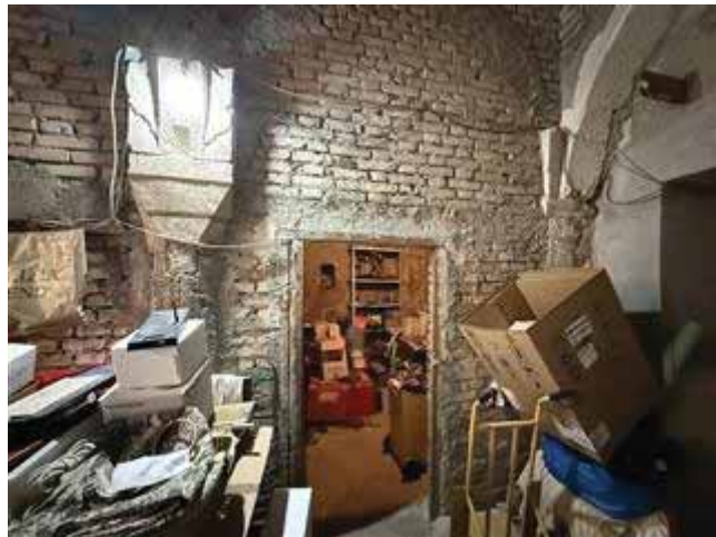
Accesso all'altro vano del sub.27
