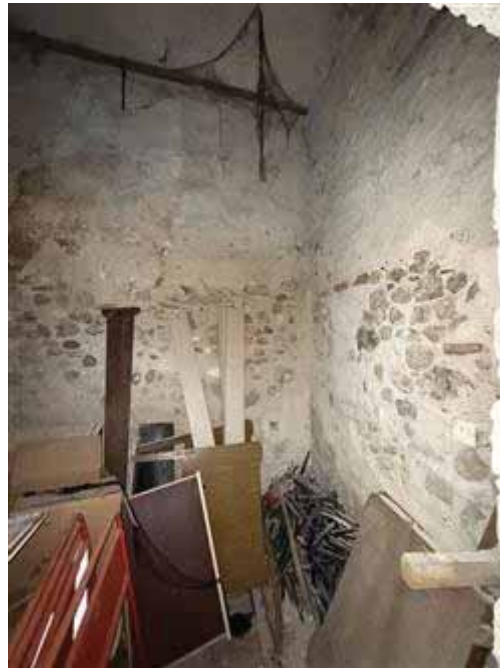
locale del sub.22
