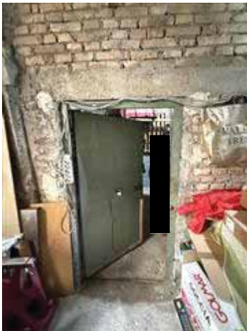
Accesso ad un vano del sub.27
