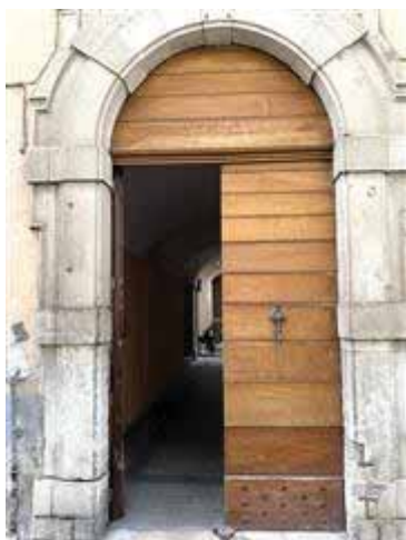
Portone di accesso al palazzo principale
