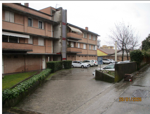
Foto n. 3: prospetto Sud-Est da Via Bidasio Degli Imberti D.
