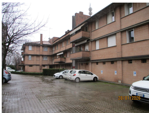
Foto n. 1: prospetto Nord da area interna retrostante
