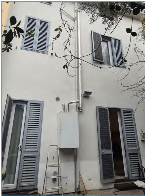
Fronte tergale dell' edificio
