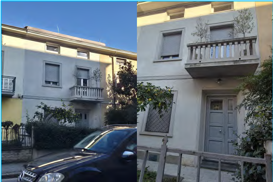
Fronte dell' edificio sulla Via Carlo Livi
