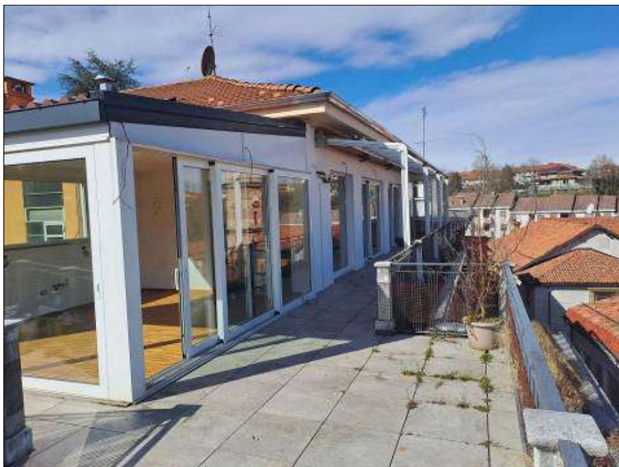
Foto 20 – Appartamento p. 4° - Terrazzo
