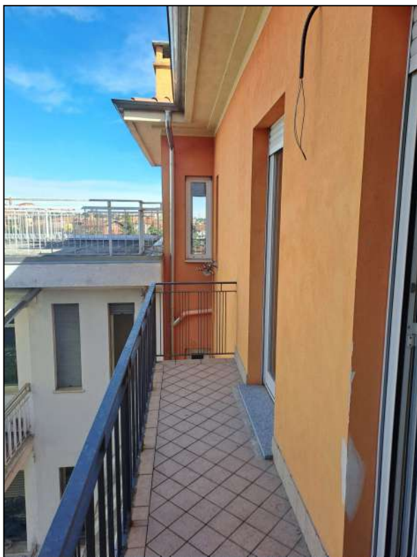
Foto 17 – Appartamento p. 4° - Balcone su prospetto Ovest
