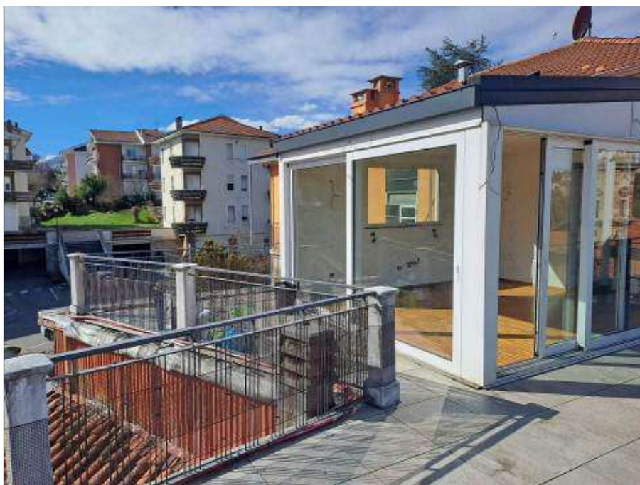
Foto 21 – Appartamento p. 4° - Terrazzo
