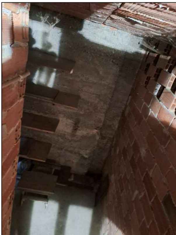
Foto 22 – Cantina p. T (sub. 32)
