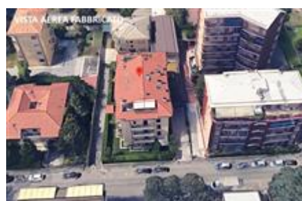
VISTA AEREA FABBRICATO
