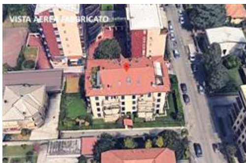
VISTA AEREA FABBRICATO
