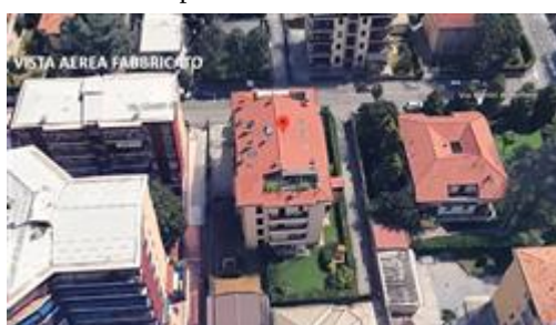
VISTA AEREA FABBRICATO
