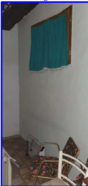
Particolare finestrella su ripostiglio e camera
