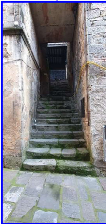
Particolare scala che conduce all'ingresso
