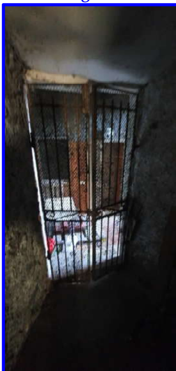
Particolare altro ingresso da Via Peri n.8
