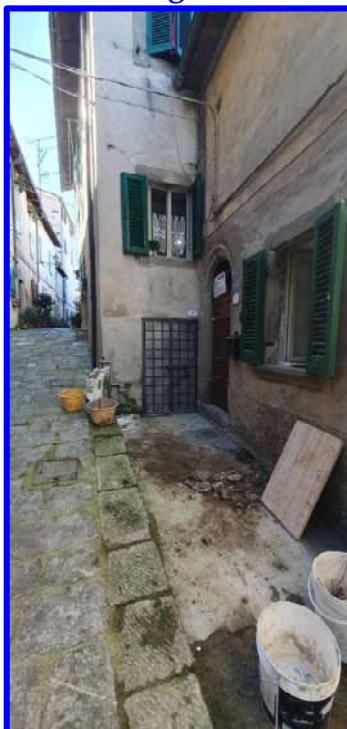
Particolare altro ingresso da Via Peri n.8
