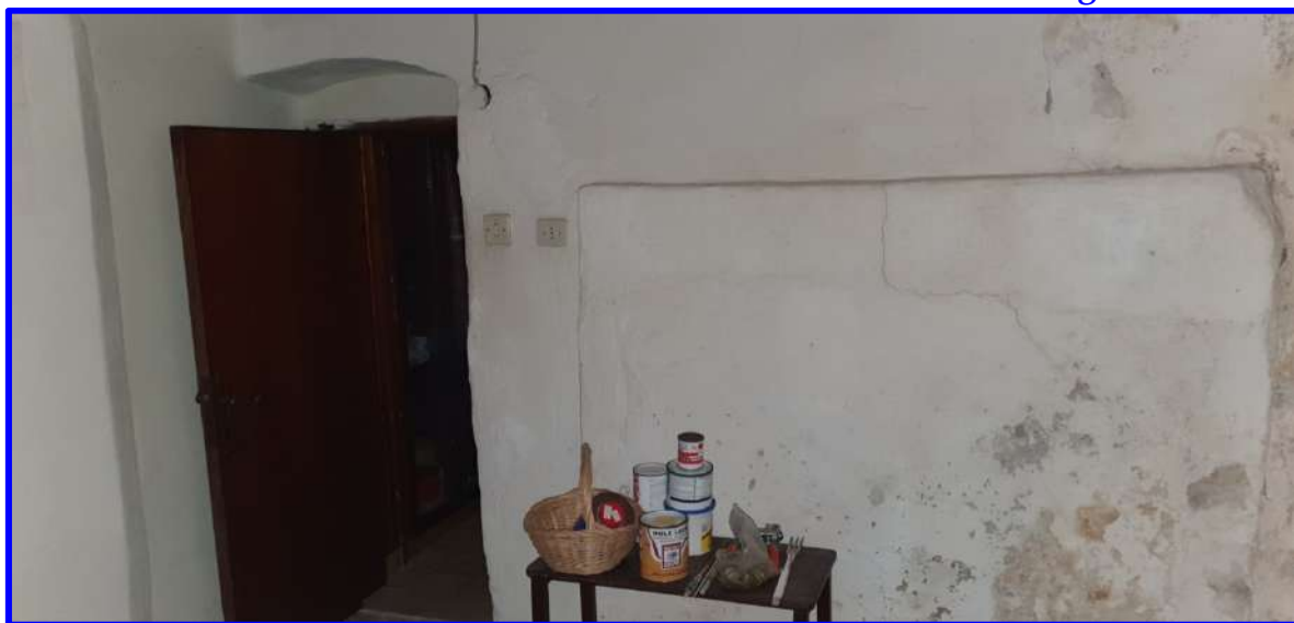
Particolare dell'ingresso della cantina
