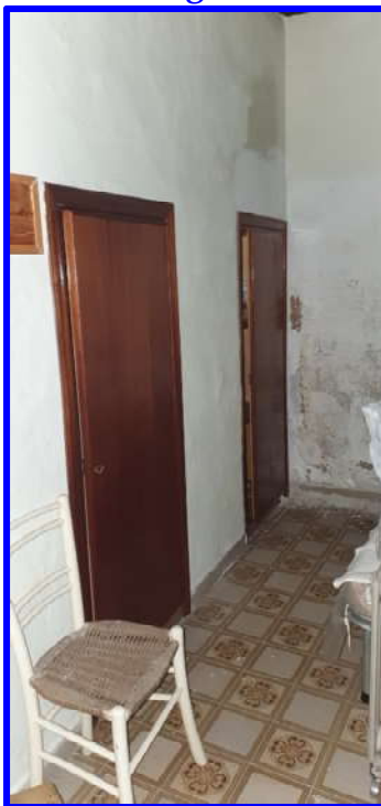
Particolare armadi a muro nel ripostiglio
