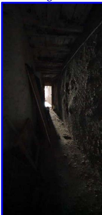
Particolare altro ingresso da Via Peri n.8
