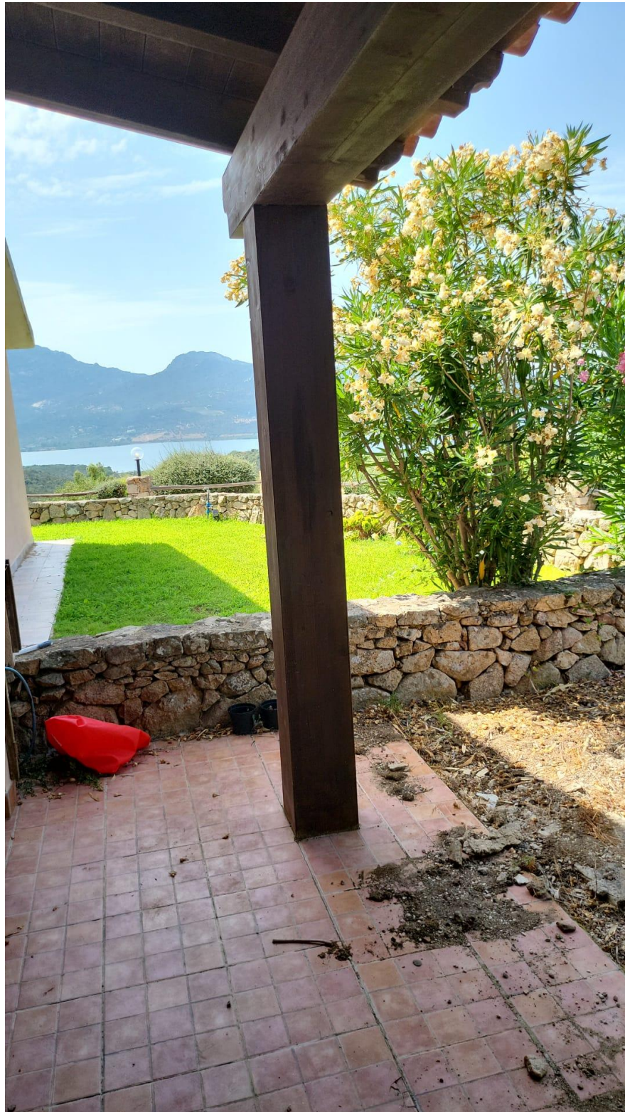
Foto 3 – muro di confine con la particella 2561
