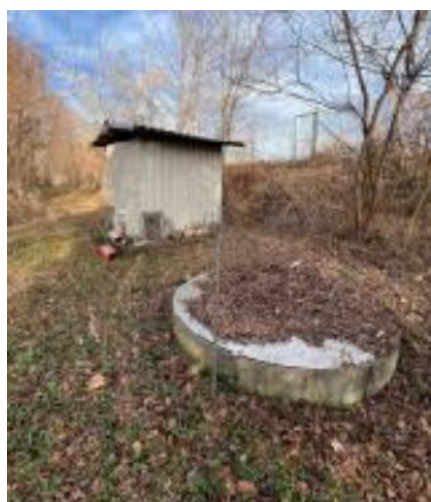
Figura 3.17 – Vista lato ovest depuratore Va-7.
