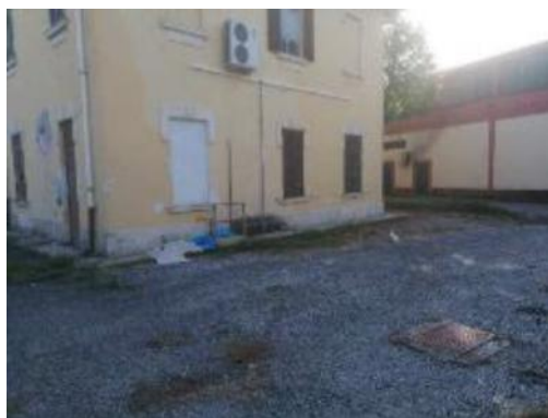
Figura 3.5 – Vista serbatoio Si-3.
