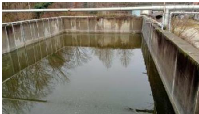
Figura 3.11 – Vista vasca fuori terra Va-1.
