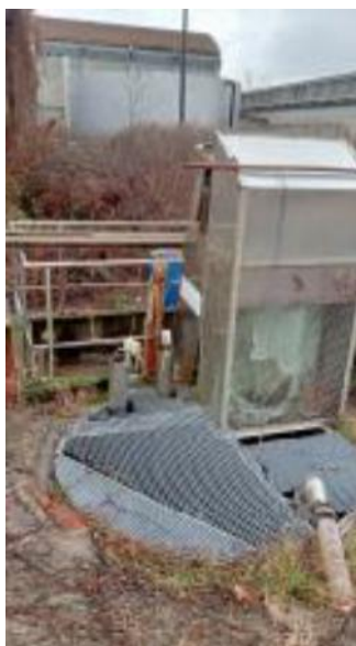
Figura 3.12 – Vista vasca fuori terra Va-2.
