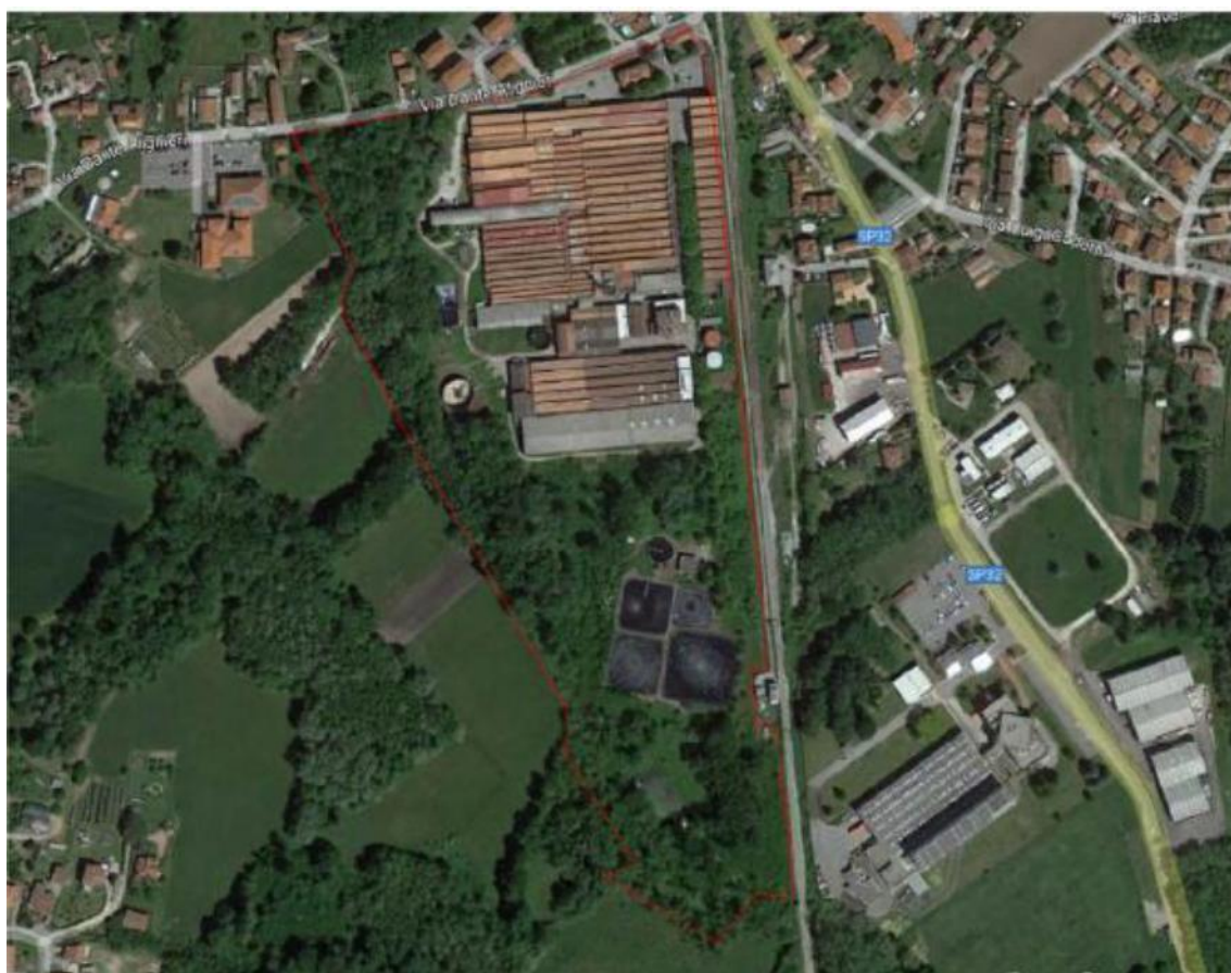
Figura 1.1: Individuazione del Sito (area all'interno del perimetro rosso)
