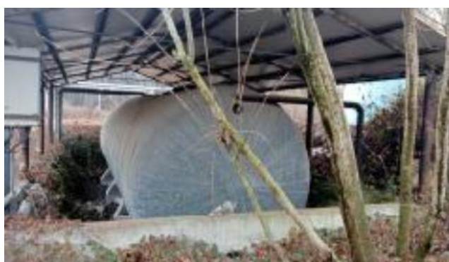
Figura 3.10 – Vista serbatoio Sa-6.
