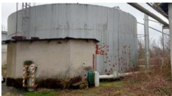
Figura 3.7 – Vista serbatoio Sa-3.
