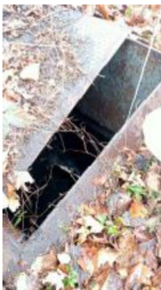
Figura 3.13 – Vista vasca fuori terra Va-3.
