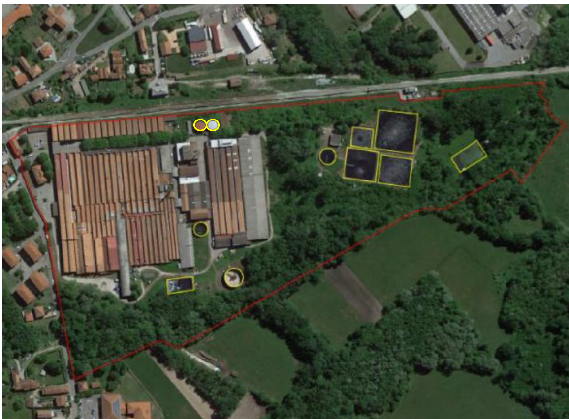
Figura 2.1 – Foto satellitare con individuazione del perimetro del Sito (in rosso) e delle principali vasche e serbatoi presenti nelle stesse (in giallo).
