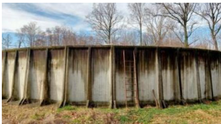
Figura 3.16 – Vista di sedimentazione Va-6.
