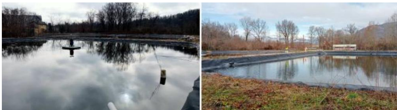
Figura 3.14 – Vista vasche bacini di trattamento e sedimentazione Va-4.
