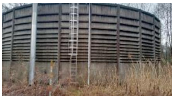
Figura 3.8 – Vista serbatoio Sa-4.
