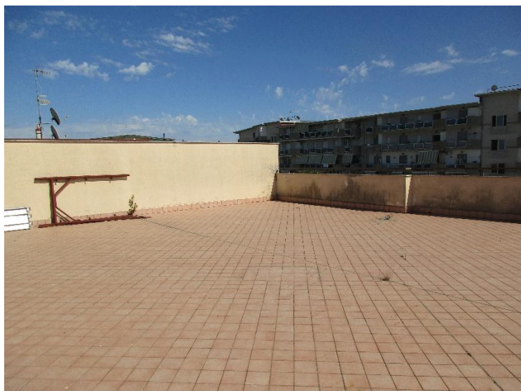
Foto n.14-20: Melito di Napoli, via delle Ginestre n.14/a. sub.4, piano II. Interni, balcone e terrazzo di copertura, particolari
