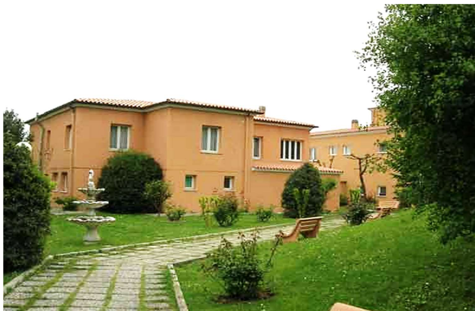
Vista del Fabbricato
