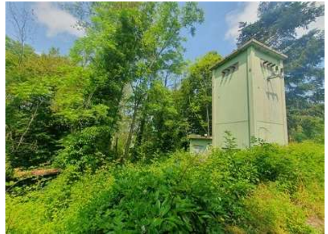
Centrale Elettrica (A)
