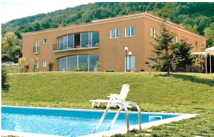
Vista del Fabbicato
