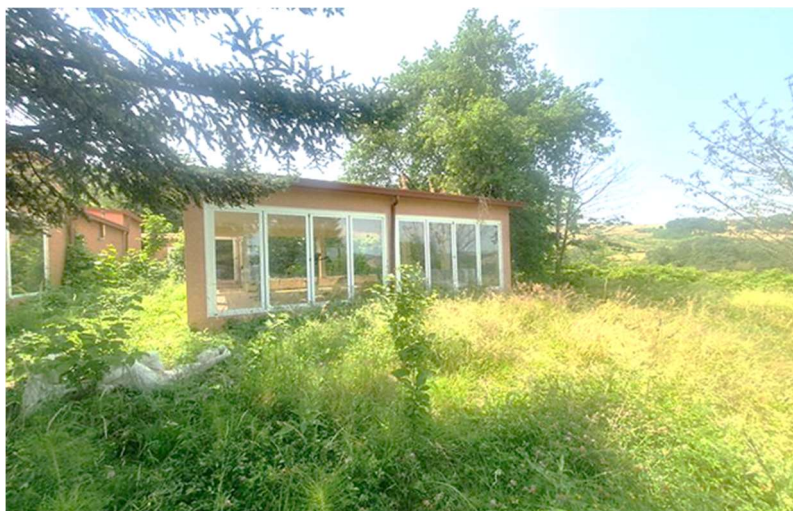
Foto 1- Vista del Corpo Palestra (Area di Sedime Sub.6)
