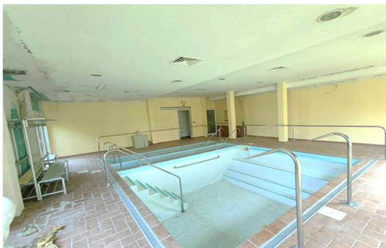
Foto 2- Vista del Sub.5 PT (Piscina 1)
