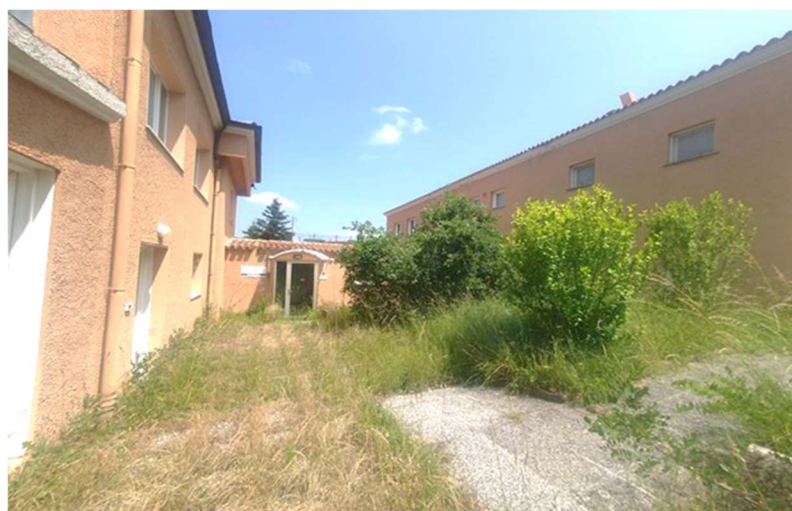
Foto 2- Vista del Fabbricato
