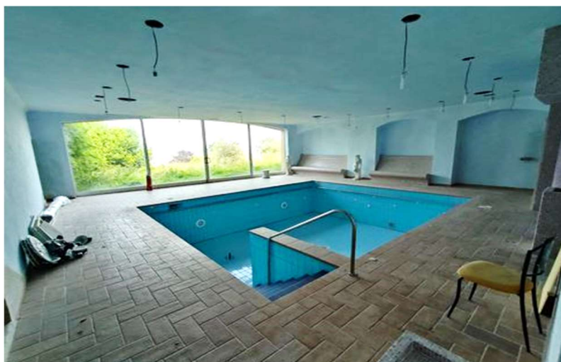
Foto 4- Vista del Sub.5 PT (Piscina 2-Sala Piscina)
