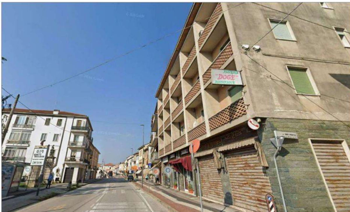
Vista del fabbricato su cui insiste l'immobile in oggetto Fonte Google Maps
