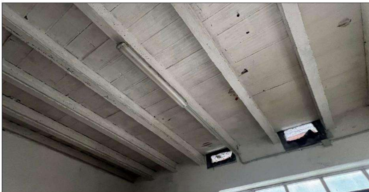
Vista del magazzino sub. 28
