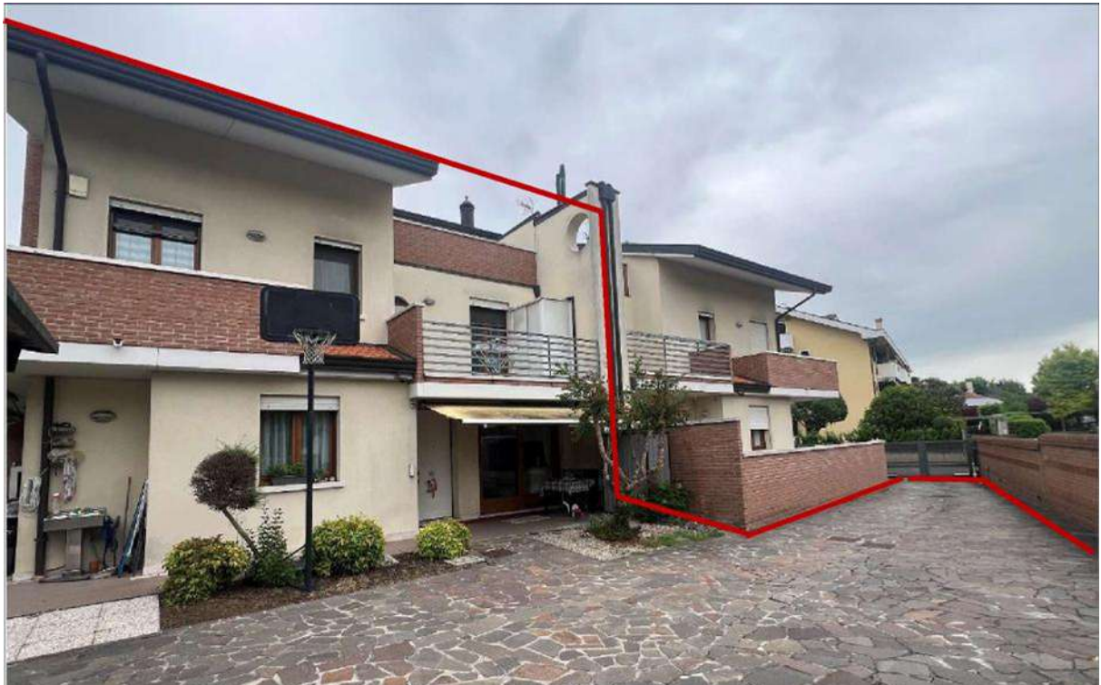
Vista dell'immobile da Sud-Ovest
