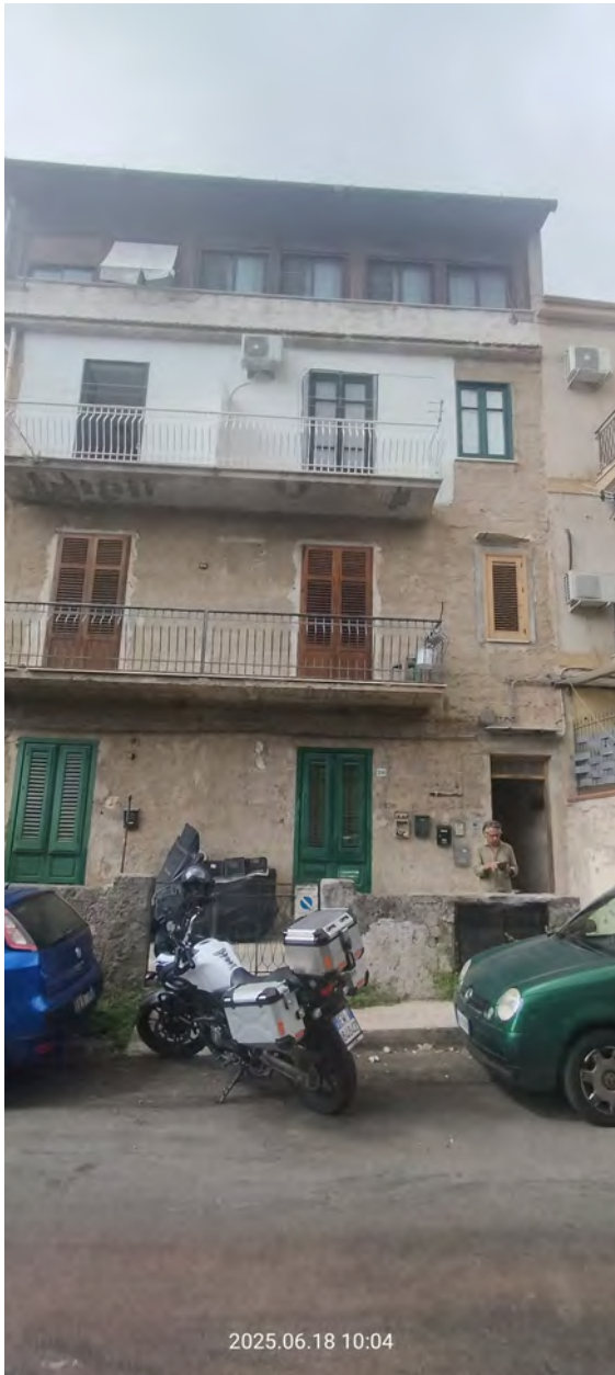
Foto 1- Vista prospetto da via San Martino
