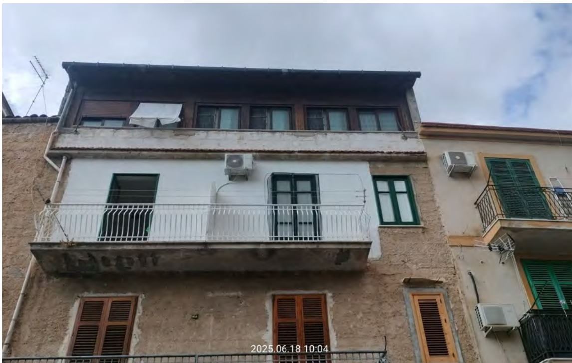
Foto 3 - Vista veranda immobile
