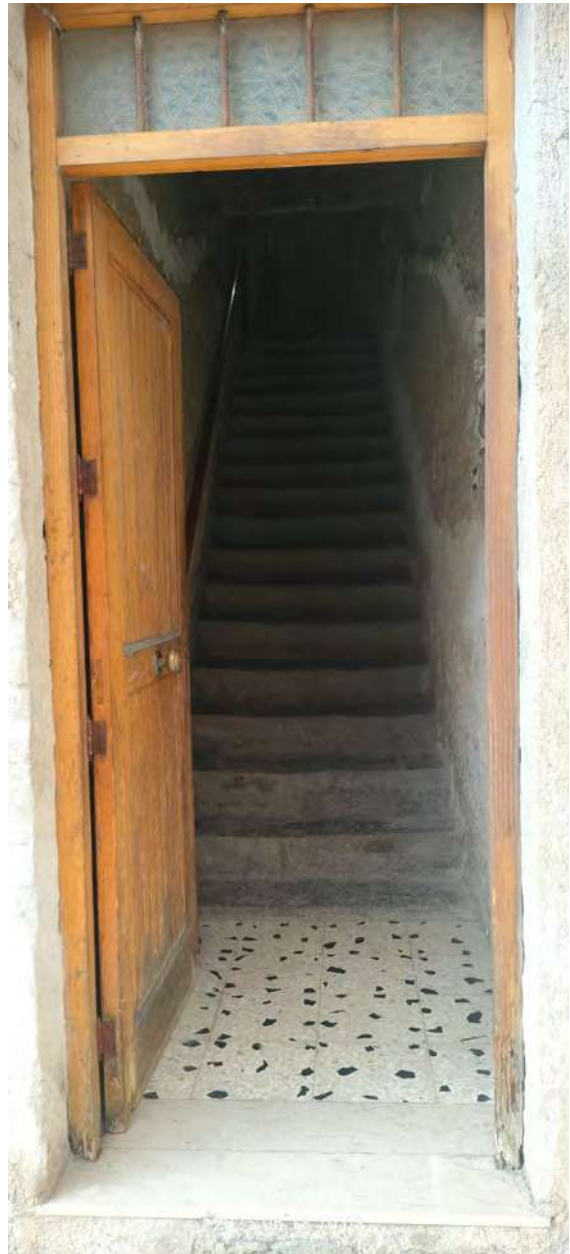
Foto 2- Vista portone di ingresso civ. 230/b
