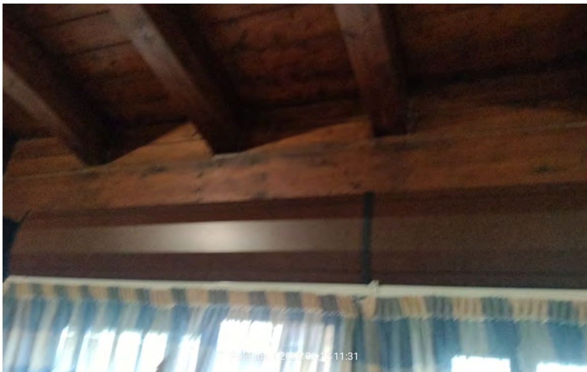
Foto 19 – Particolare copertura veranda
