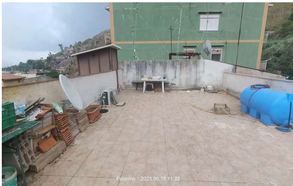
Foto 21 – Vista lastrico solare
