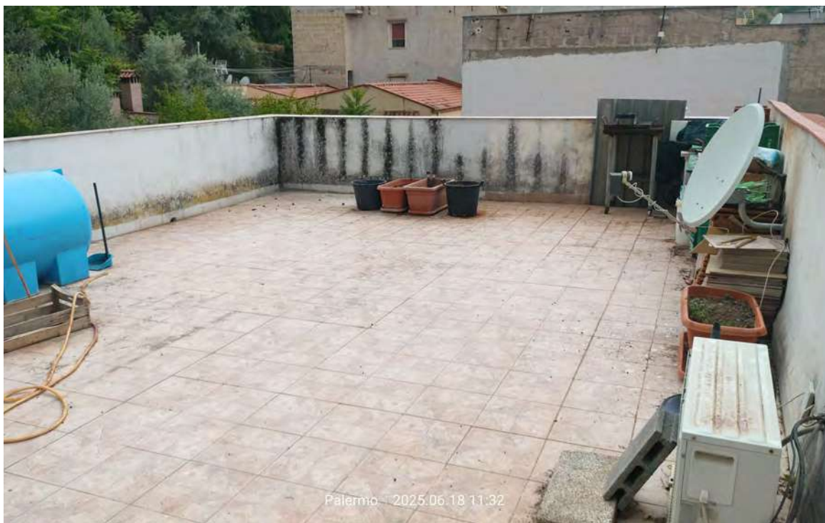
Foto 20 - Vista lastrico solare
