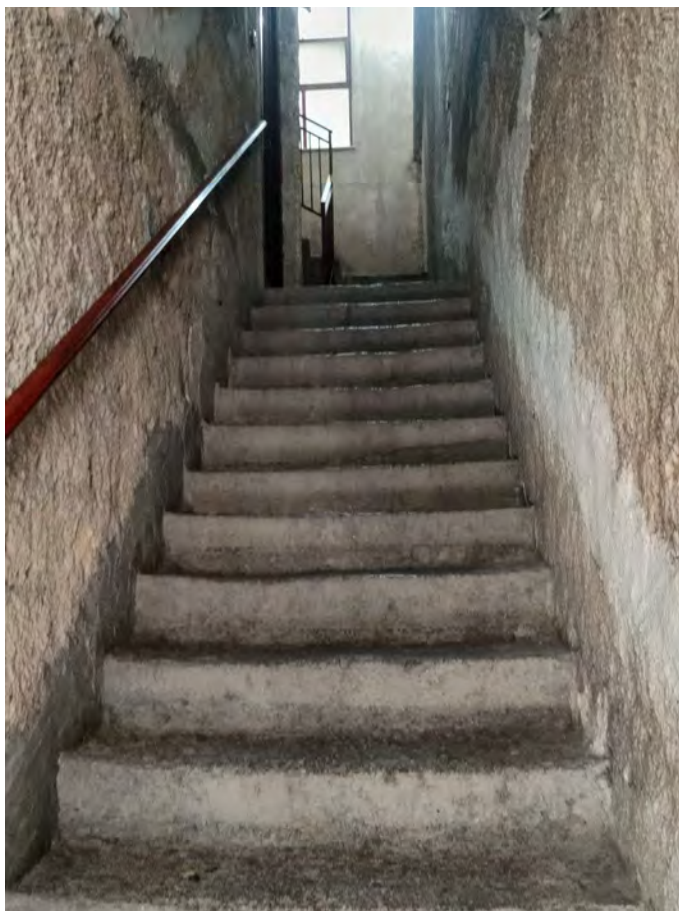
Foto 4 - Vista vano scala
