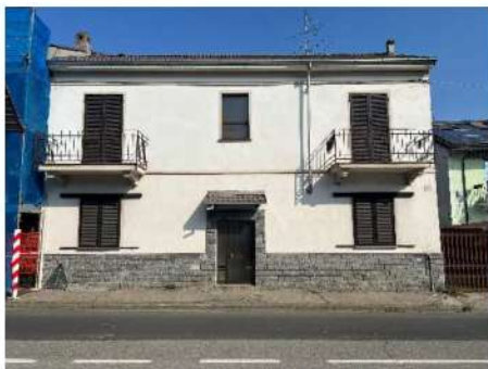
Vista Esterna Fabbricato
