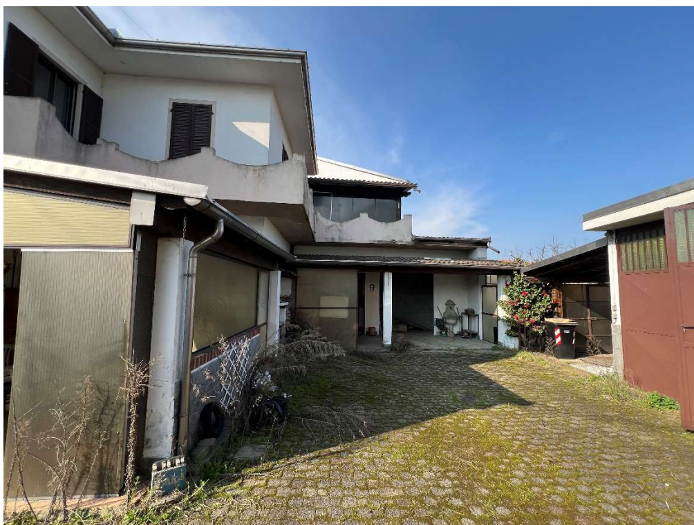
Vista esterna abitazione – Cortile interno
