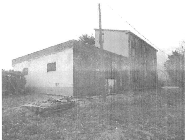
Foto 3 – Esterno fabbricato - retro
