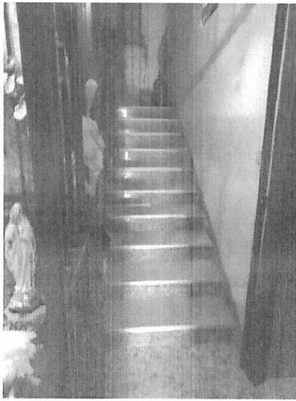
Foto 11 – Scala di accesso al piano 1°
