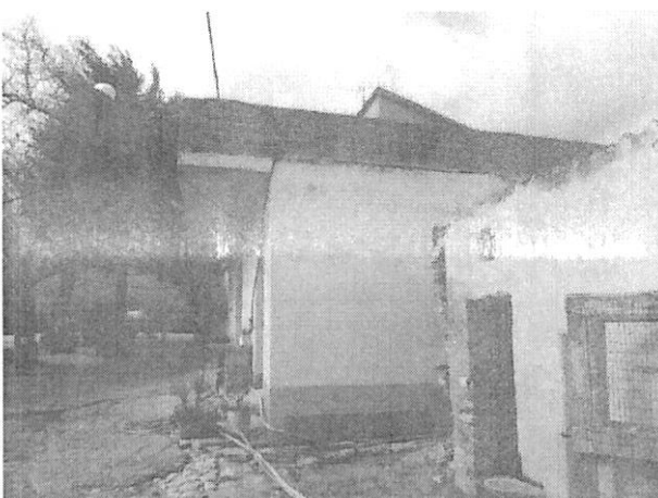
Foto 4 – Esterno fabbricato – parte nuova
