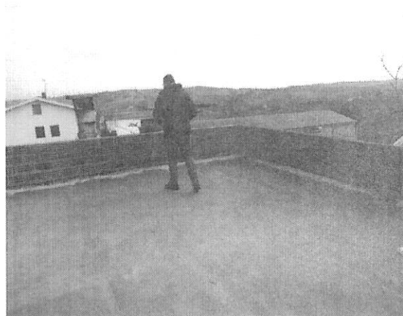
Foto 16 – Terrazzo Piano 2° - sottotetto
