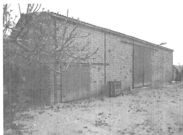
Foto 19 – Capannone Garage Sub. 4
