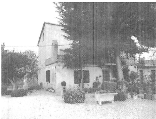
Foto 1 – Esterno fabbricato residenziale Sub. 2
