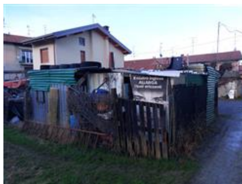
vista sud-ovest tettoia su mapp. 346
