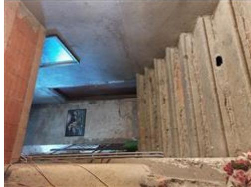
vano scala comune con ingresso al passaggio comune al p. primo
