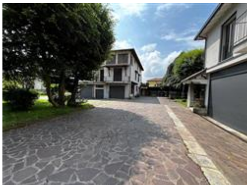
Il fabbricato visto dal confinante mappale 591
