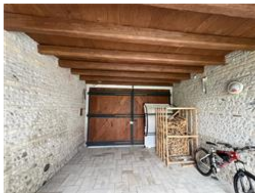
sottoportico di passaggio
