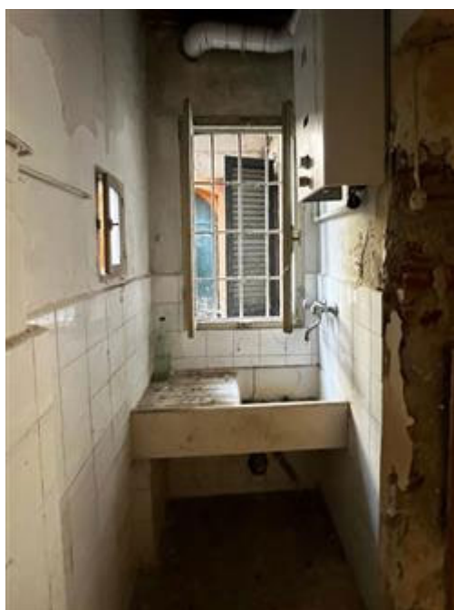
Vano di servizio al piano terra
