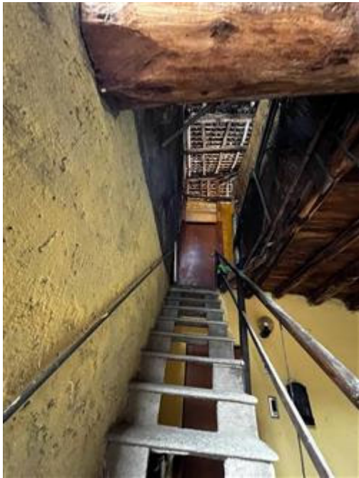
Scala di accesso al piano superiore
