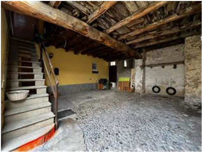
Vista interna del porticato
