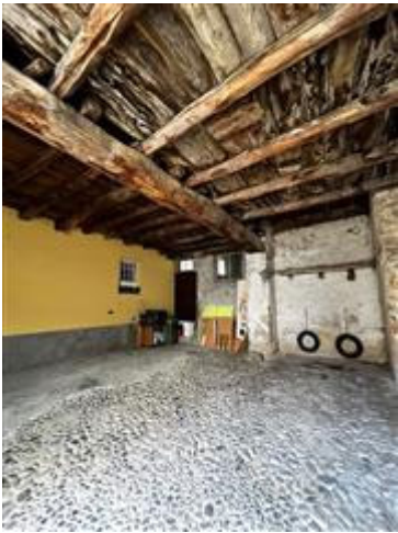
Vista interna del porticato
