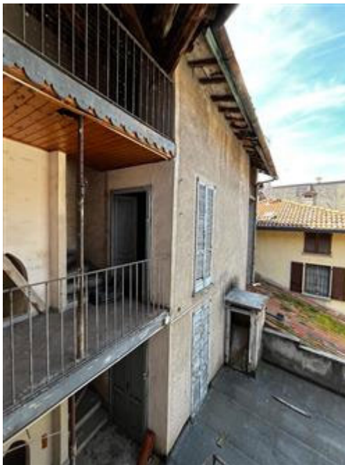
Il fronte interno ed il vano latrina sul terrazzo
