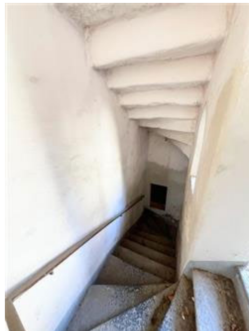
Il vano scala
