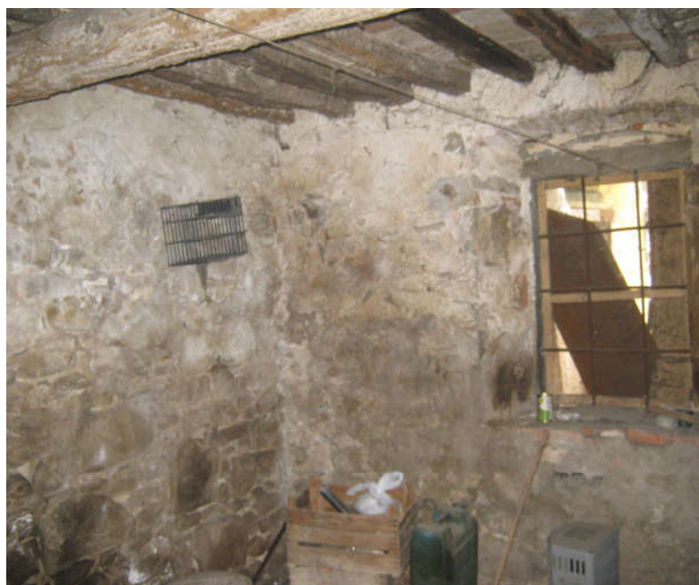
Foto 8 – 364 / 10 Cantina P. Terra -
