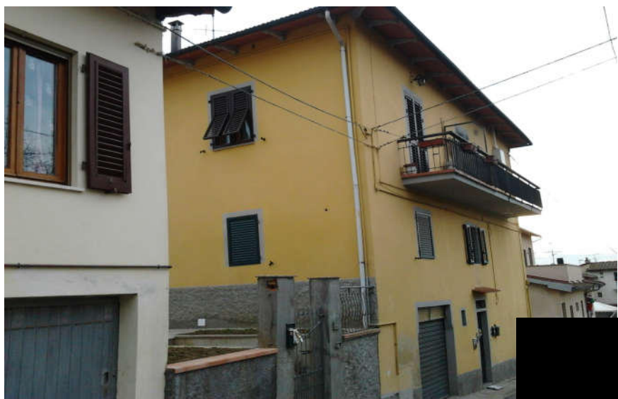
FOTO 1 – 364/10 Ingresso Fabbr. Da Via L. Pignotti , 42 .
