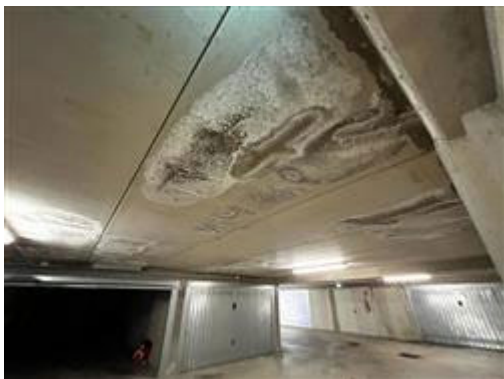
Foto 4 Stato di fatto solaio di copertura
