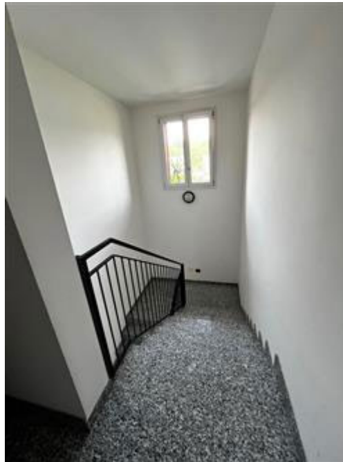
Il vano scale interno
