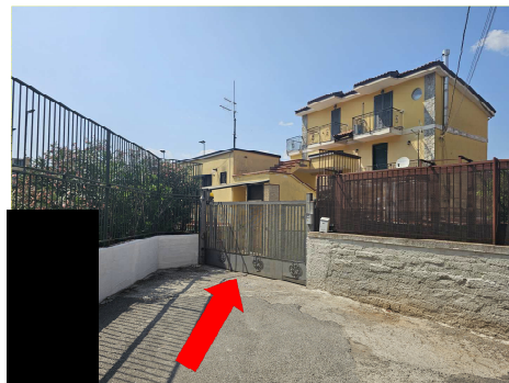
Figura 5 – Accesso alla corte del fabbricato
