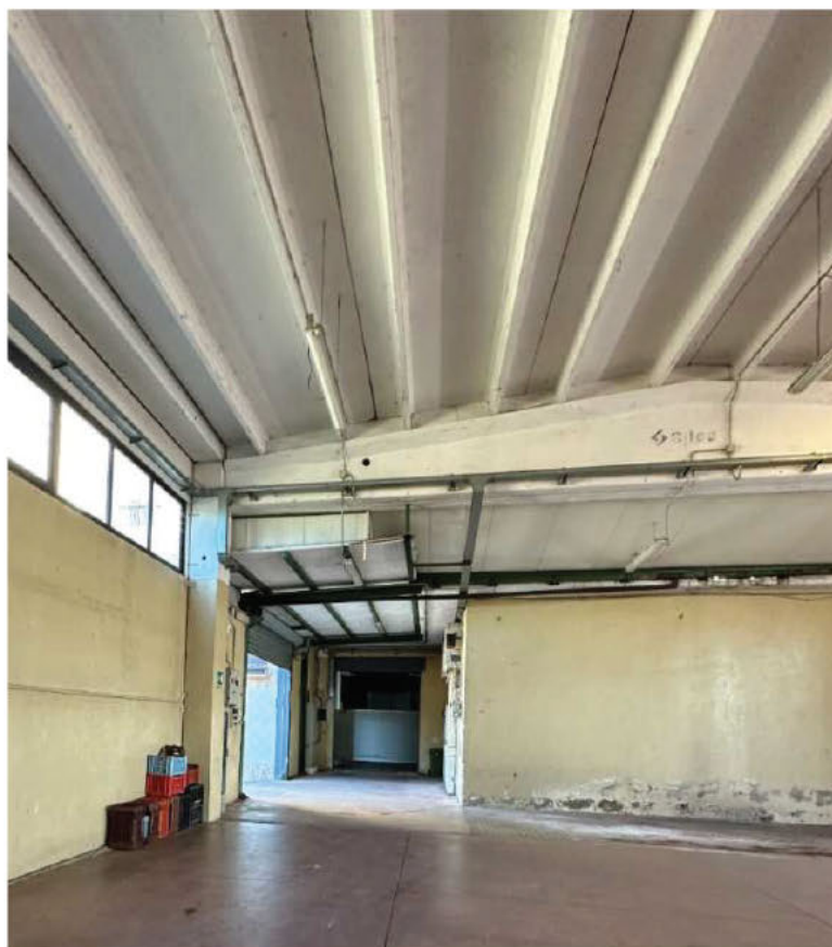
Foto 1: Accesso all'immobile confinante di altra proprietà. La freccia indica la posizione del quadro elettrico comune alle p.lle 152 sub 3 e 198.
