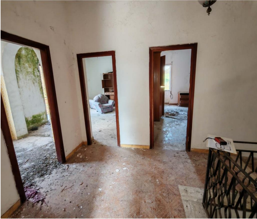
10 interno piano primo
