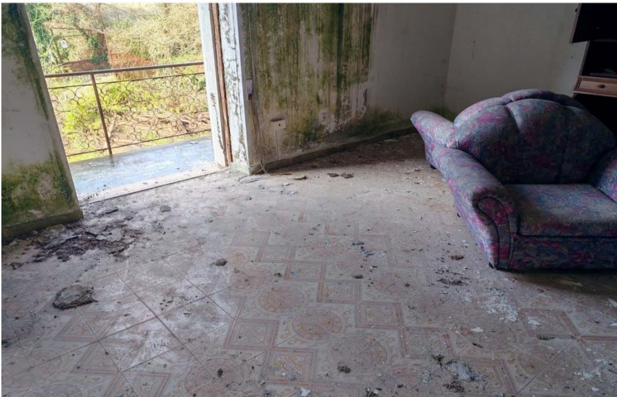
11 interno piano primo
