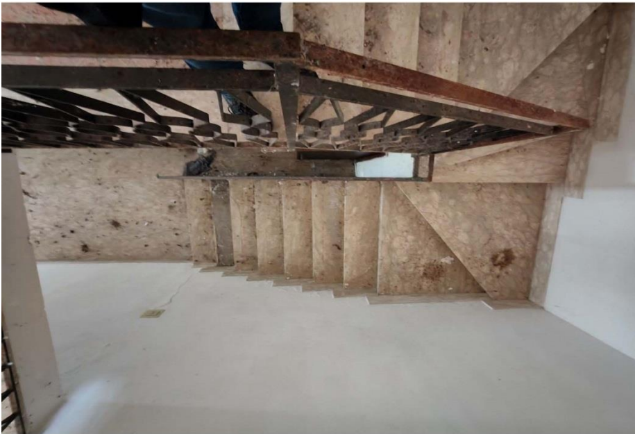
8 scala accesso al piano primo
