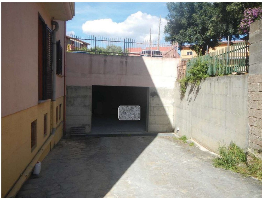
Foto 45: accesso ad autorimessa da esterno
