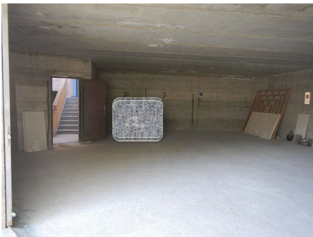
Foto 46: vista interna autorimessa
