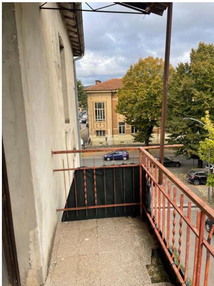
Foto 11 – Vista del balcone (sub 14)
