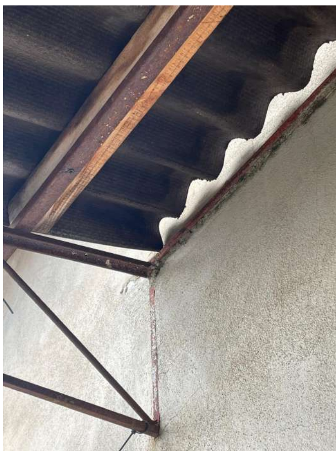
Foto 12 – Dettaglio della pensilina (sub 14)
