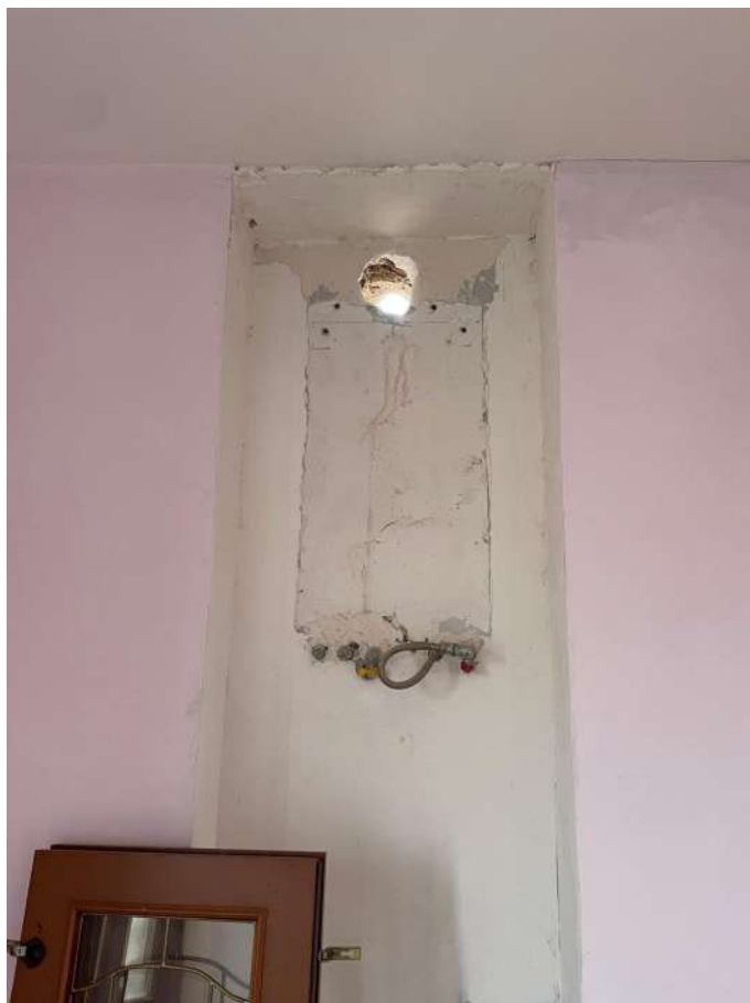
Foto 23 – Dettaglio della posizione di una delle caldaie rimosse
