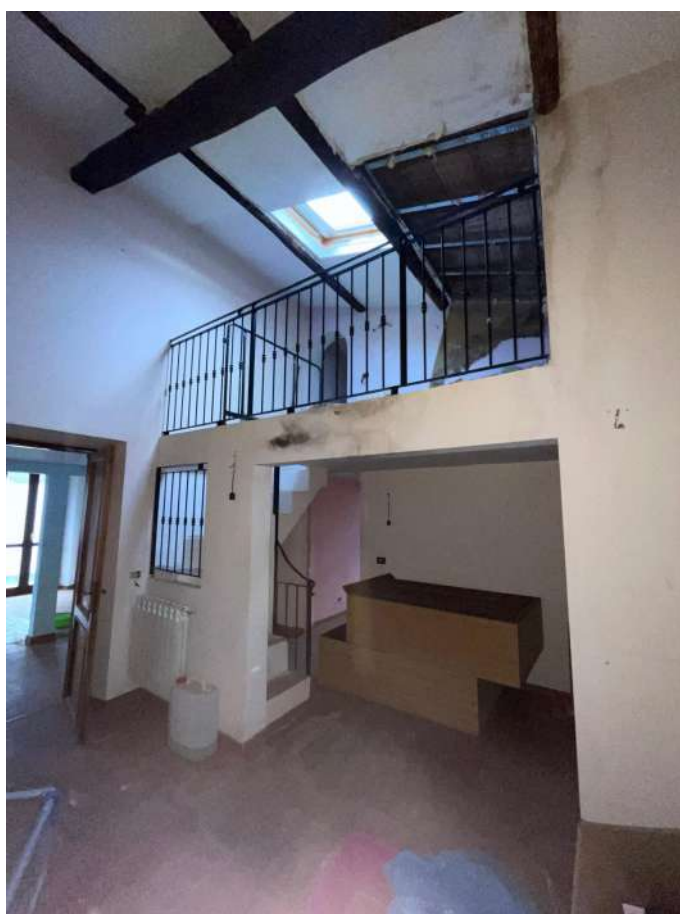
Foto 8 – Vista del soppalco (sub 13)
