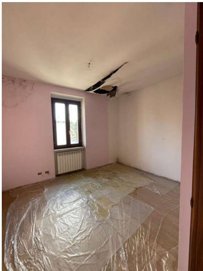
Foto 15 – Vista della camera (sub 14)
