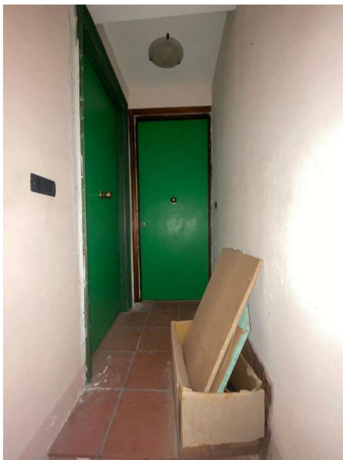
Foto 4 – Vista del pianerottolo comune
