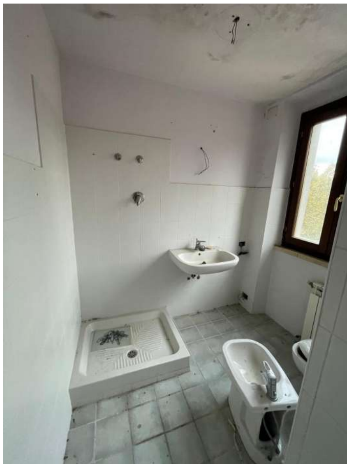
Foto 19 – Vista del bagno (sub 14)
