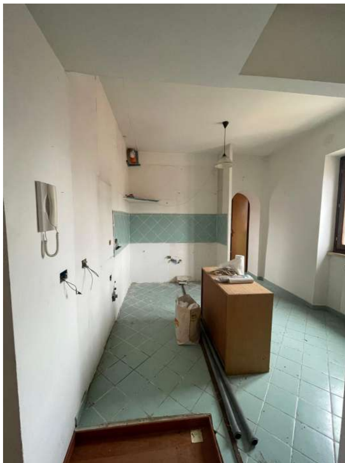
Foto 5 – Vista dell'ingresso – cucina (sub 13)
