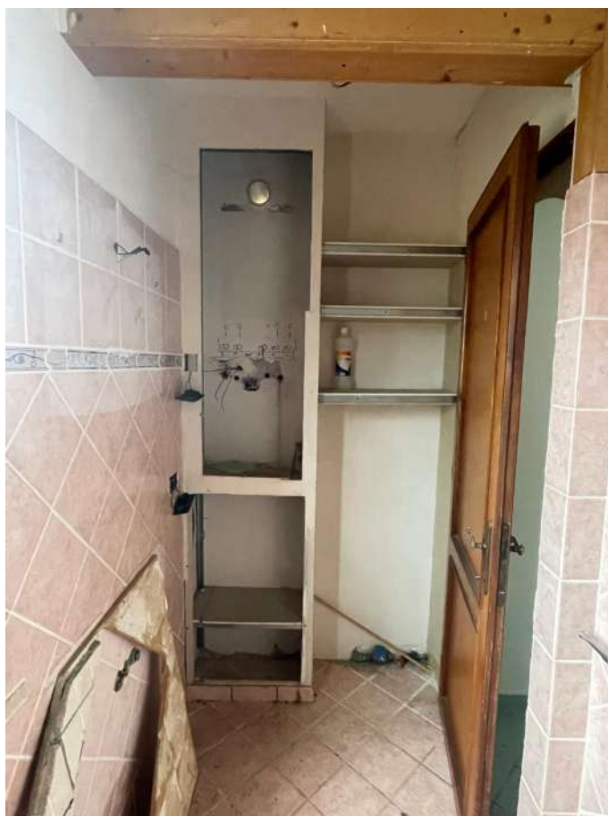
Foto 24 – Dettaglio della posizione di una delle caldaie rimosse
