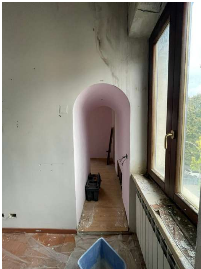
Foto 17 – Vista del passaggio (sub 14)
