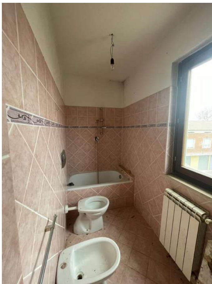
Foto 6 – Vista del bagno (sub 13)
